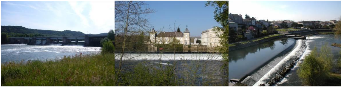
Figure 6 Barrages de Poses sur la Seine (gauche), de Laubardemont sur l'Isle (milieu) et de Coutras sur la Dronne (droite)
