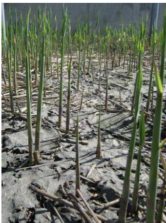
Figure 14 : Surface d'un FPv eaux usées brutes en début de croissance des végétaux
