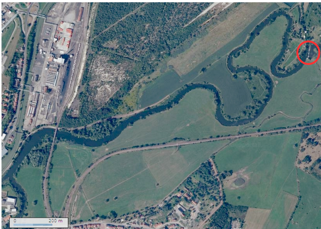
Figure 49 : Vue aérienne du site de Sarralbe centre avec le seuil aval entouré d'un cercle rouge (source Geoportail)
