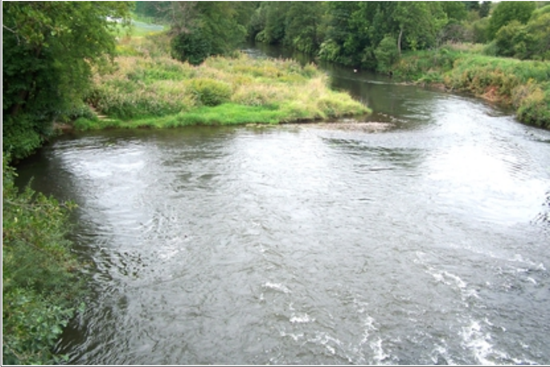
Figure 98: Vue du rétrécissement du lit depuis le pont
