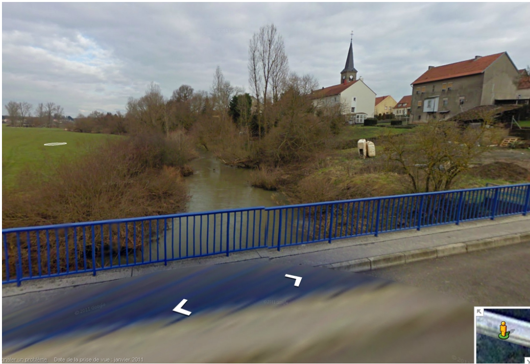
Figure 65: Vue de l'Albe en aval de la station depuis le pont de la D156F via Google Streets (date de la prise de vue : janvier 2011)
