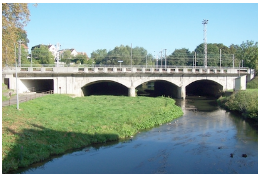
Figure 7 : le pont SNCF depuis le pont routier amont à bas débit
