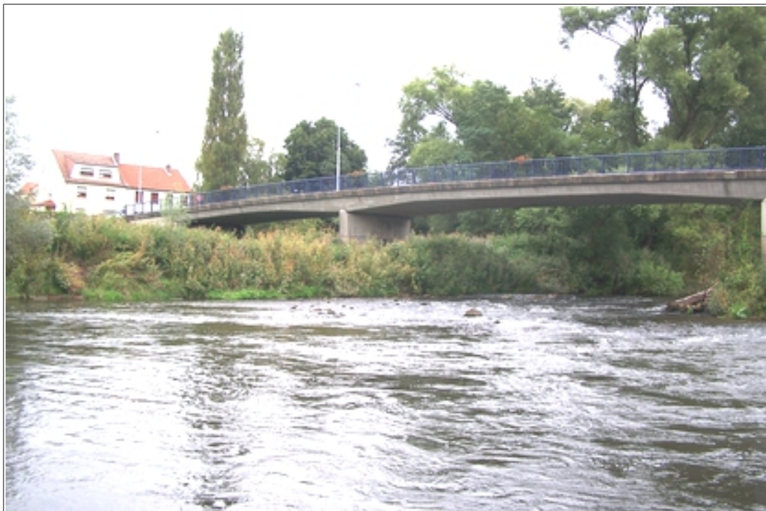
Figure 97: Vue de la section depuis l'aval
