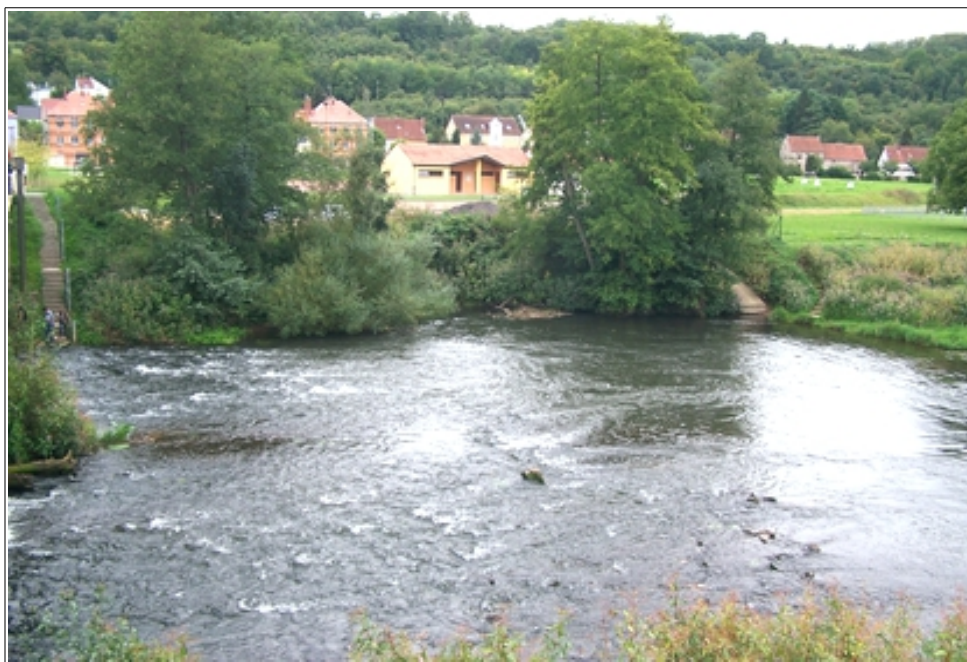
Figure 100 : Vue du radier naturel situé à l'aval de la station depuis la rive droite
