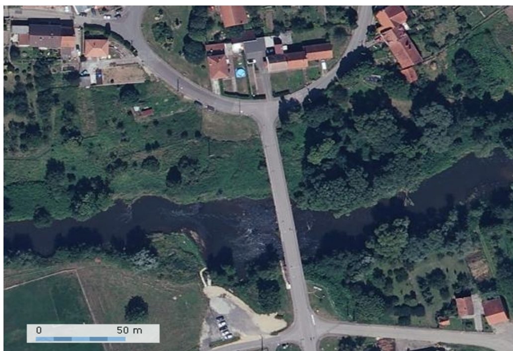
Figure 95: Vue aérienne de la station hydrométrique de Bliesbruck
