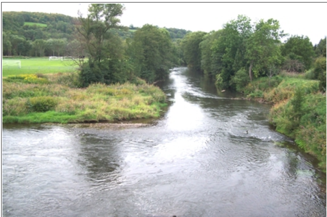
Figure 99: Vue du rétrécissement du lit depuis le pont
