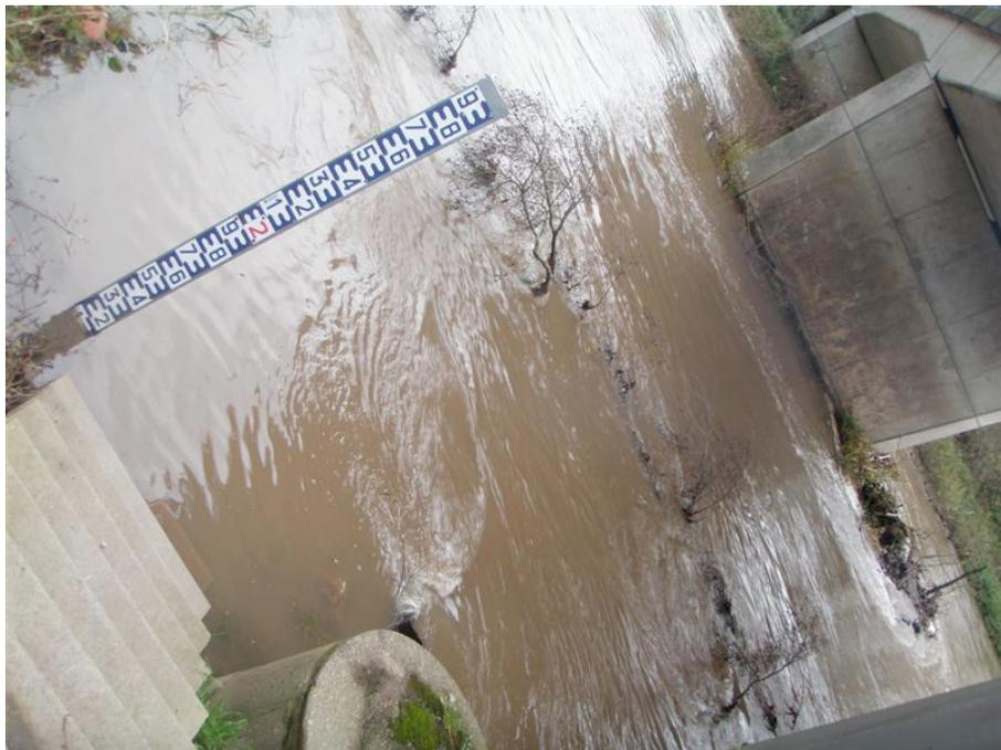
*Figure 82 : embâcle sous le pont et contre la pile de droite*
