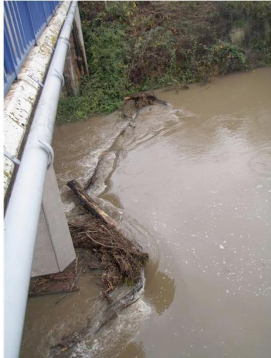
*Figure 81 embâcle sur la pile de droite*
