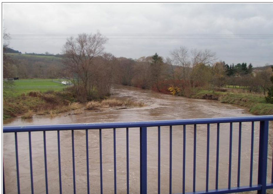
Figure 102: Vue du rétrécissement depuis le pont pendant une crue
