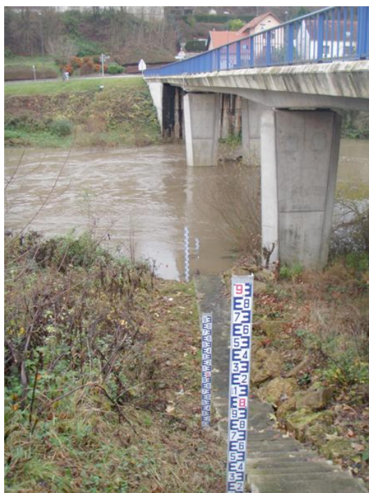
Figure 76 : vue du pont depuis l'abri de la station situé à l'aval du pont en rive gauche
