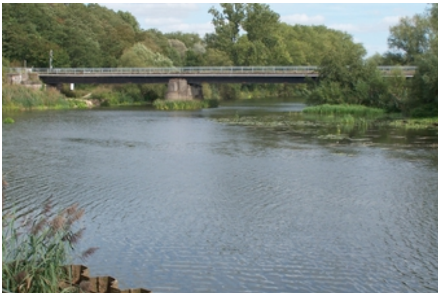
Figure 48 : vue du pont SNCF depuis l'amont
