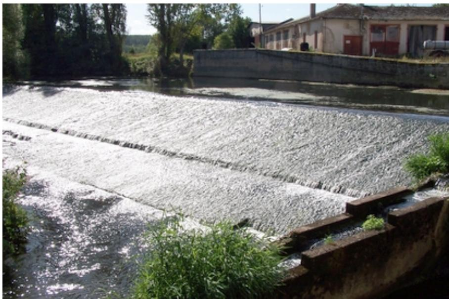
*Figure 32 rampe inclinée au niveau du moulin*
