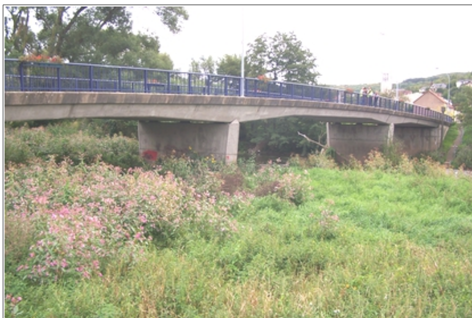
Figure 101 : vue du pont et du remblai enherbé depuis la rive droite
