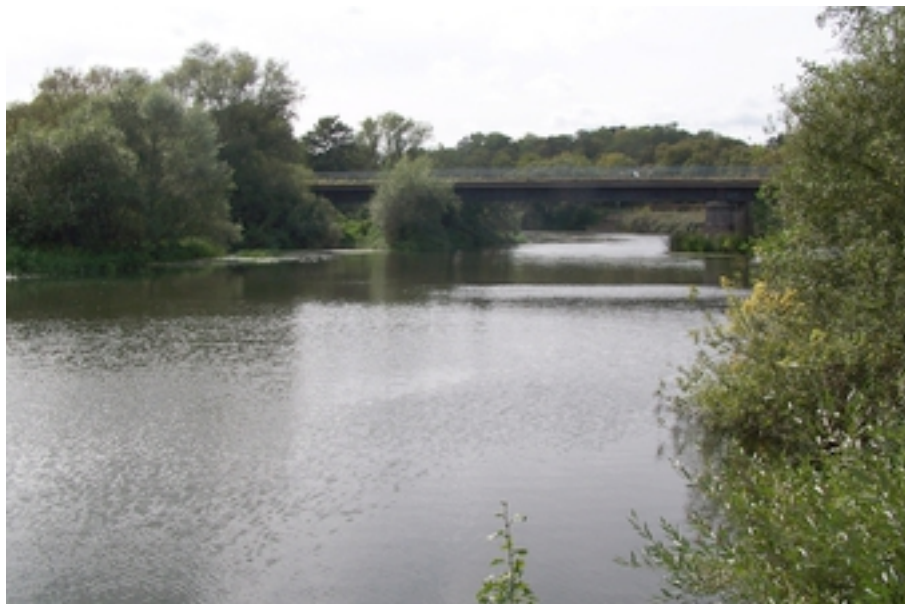
Figure 53 : pont SNCF depuis l'aval
