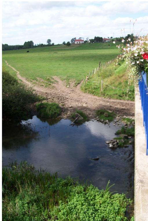
*Figure 64: Berge dégradée en rive gauche à l'amont immédiat du pont, où la rivière semble servir d'abreuvoir naturel*
