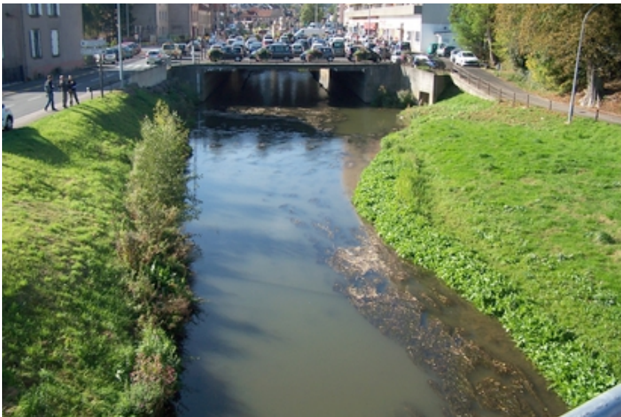
Figure 9 : le pont routier amont depuis le pont SNCF
