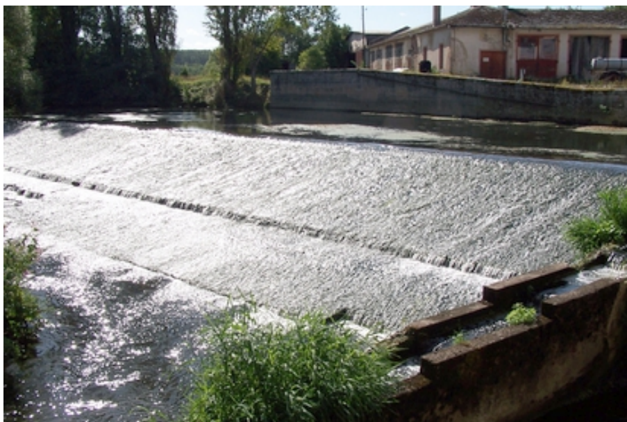
Figure 32 rampe inclinée au niveau du moulin
