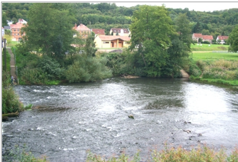
Figure 100 : Vue du radier naturel situé à l'aval de la station depuis la rive droite
