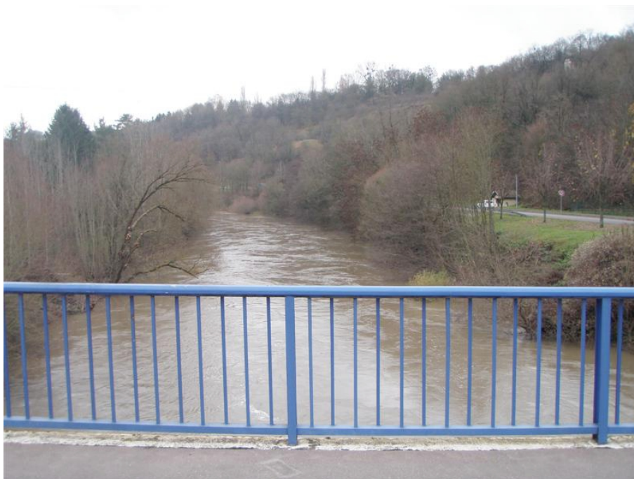
Figure 80 : vue de l'aval depuis le pont
