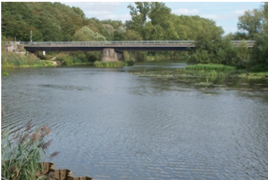
Figure 48 : vue du pont SNCF depuis l'amont
