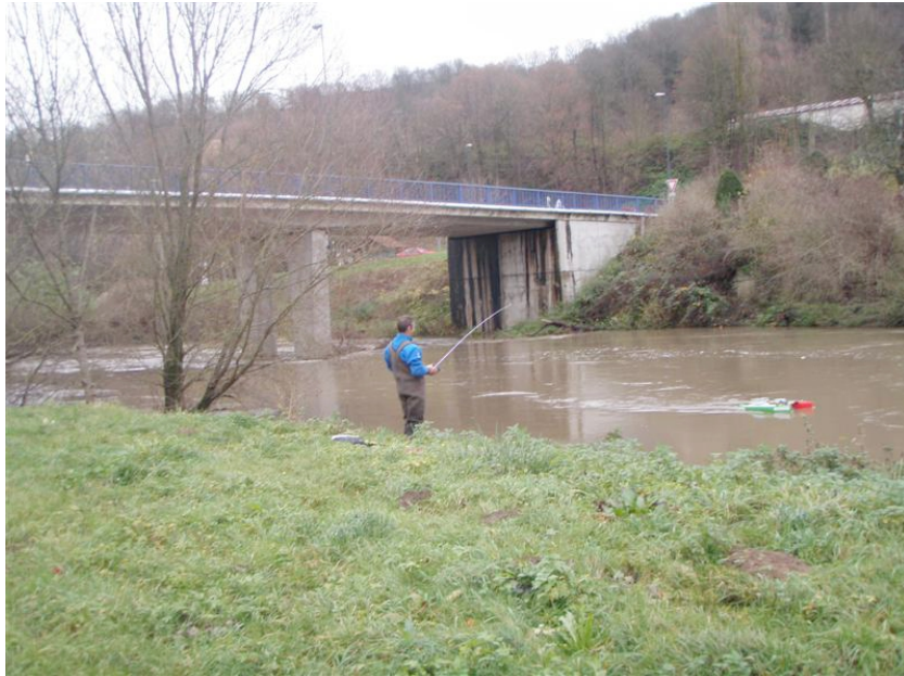
Figure 77 : vue du pont depuis le champ d'expansion situé à l'amont
