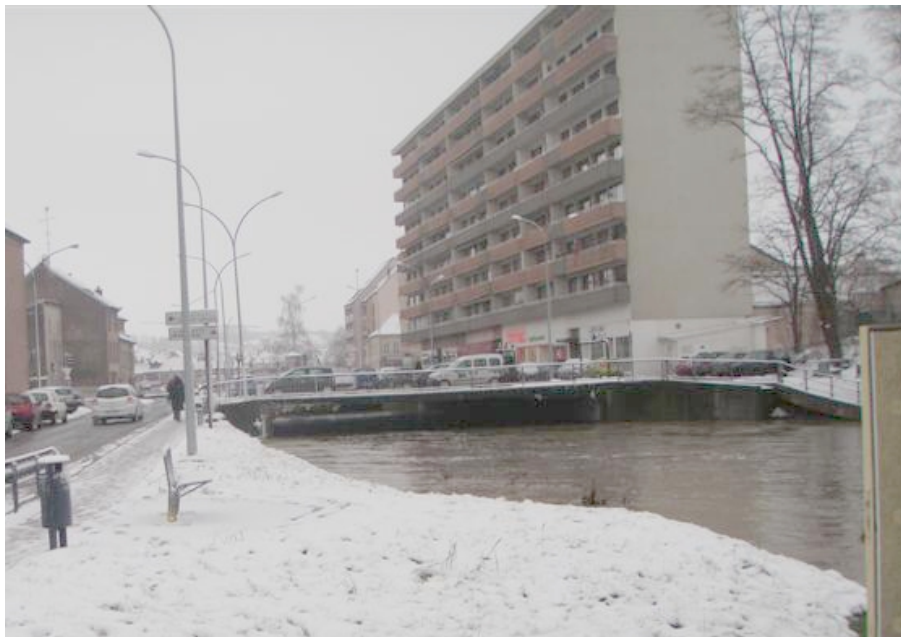
Figure 14 : le pont routier amont depuis la station lors d'une crue à fort débit
