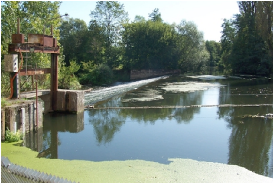
Figure 31 amont du seuil en rampe inclinée au niveau du moulin situé à l'amont de la station
