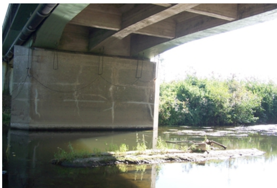
Figure 26 : dessous du pont vu depuis la section de l'échelle
