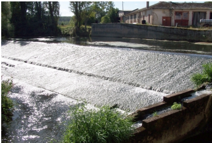
Figure 32 rampe inclinée au niveau du moulin
