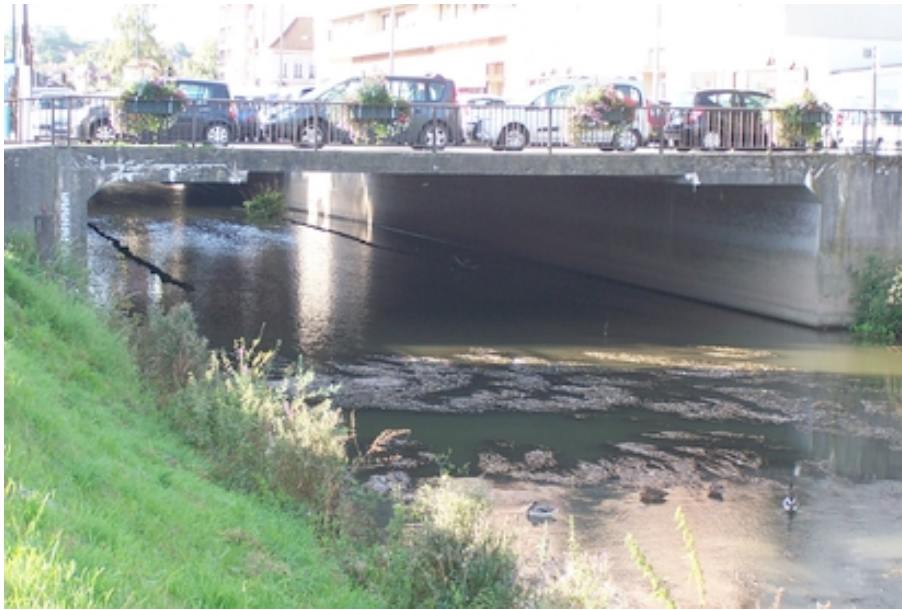
Figure 8 : aval du pont routier amont depuis la rive droite
