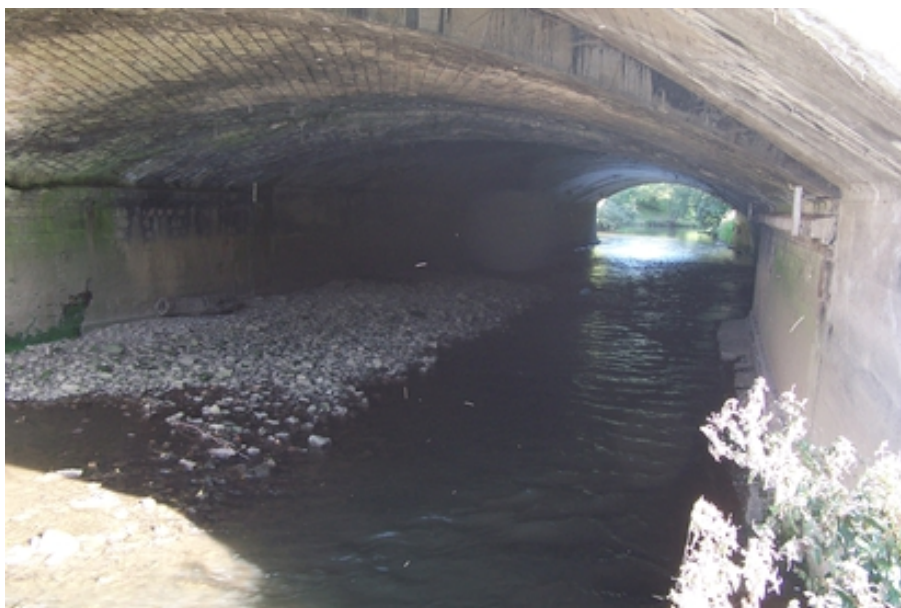
Figure 10 : intérieur de l'arche de droite du pont SNCF à bas débit
