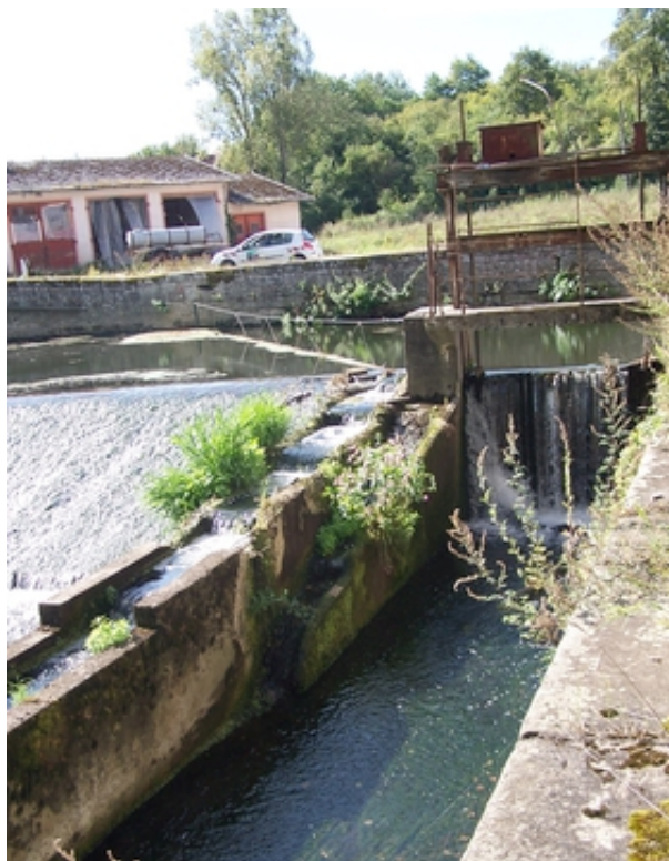
Figure 30 : vanne et seuil du moulin situé à l'amont de la station
