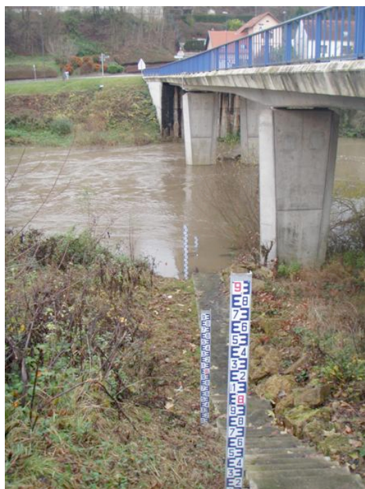
Figure 76 : vue du pont depuis l'abri de la station situé à l'aval du pont en rive gauche
