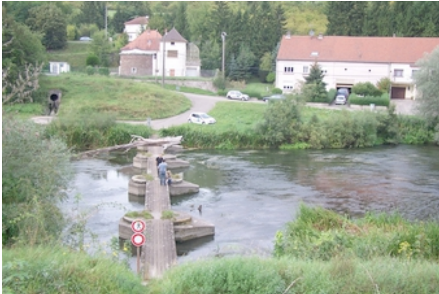
Figure 83 : passerelle submersible à l'aval de la station
