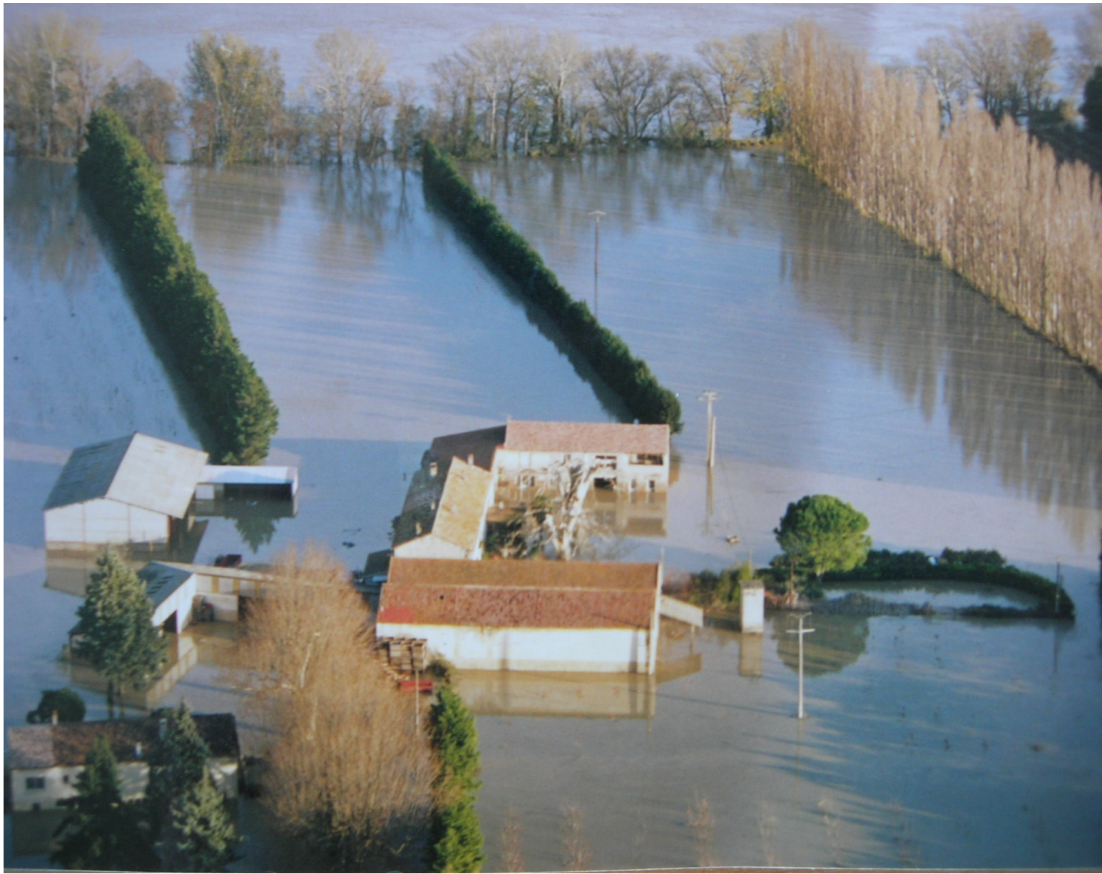
Délocalisation de bâtiment
