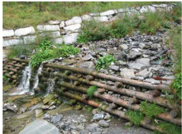
Fig. 16 - Seuil à doubles parois.
