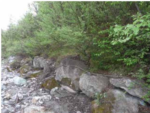
Fig. 43 - L'enrochement de pied de berge relié par un câble.
