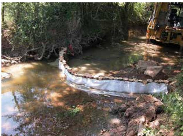
Fig. 13 - Installation d'un géotextile à l'amont du parement.
