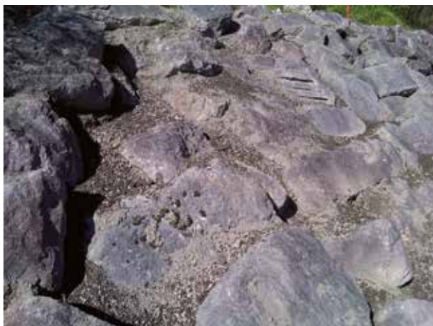
Fig. 73 - L'enrochement après le comblement des vides.
