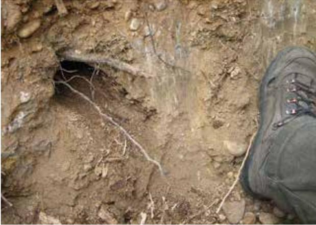
Fig. 7 - Départ de galerie créée par une racine décomposée en pied de digue dans des matériaux cohésifs.
