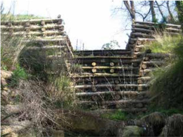
Fig. 26 - Barrage dont les ailes sont réalisées avec des longrines horizontales à Bordighera (Ligurie - Italie).
