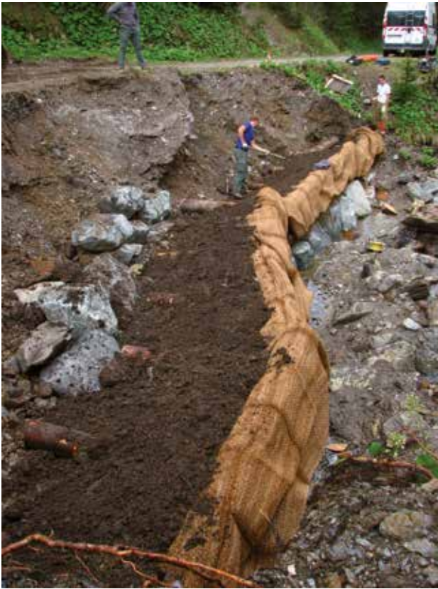
Fig. 48 - REMPLISSAGE DU CAISSON AVEC LA TERRE VÉGÉTALE DU SITE.
