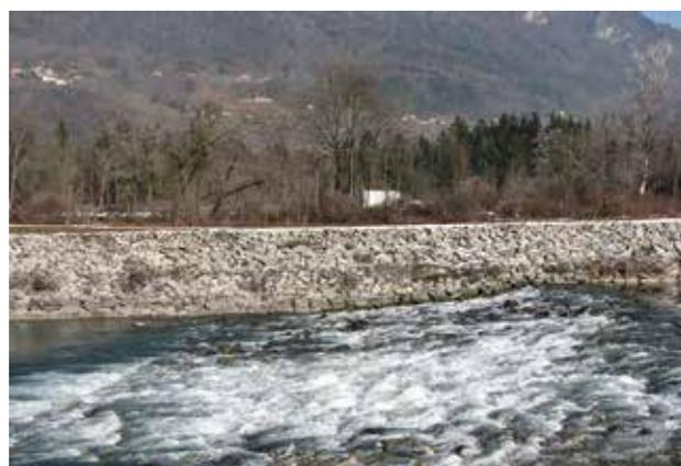
Fig. 68 - Vue de la berge sud de l'Arve au niveau du seuil de Vougy-Marignier. État de l'enrochement avant les travaux de végétalisation.
