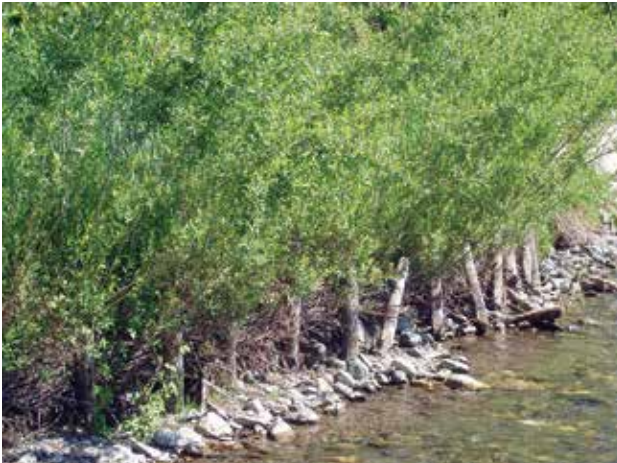
Fig. 1 - Fascine de saules à Villard-Bonnot sur le Vorz (Isère - France).
