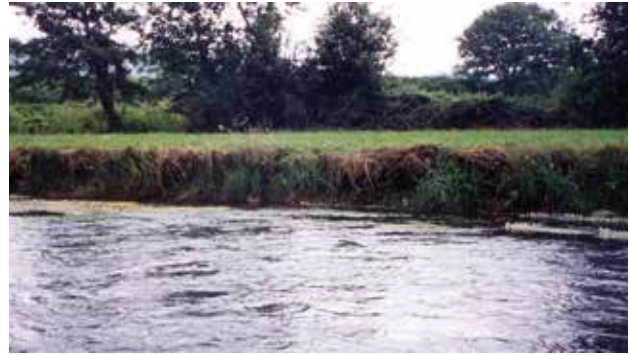
Fig. 59 - La berge de l'Adour avant les travaux.
