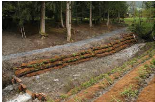
Fig. 18 - Caissons en rondins, végétalisés, pour soutenir le chemin en rive droite.
