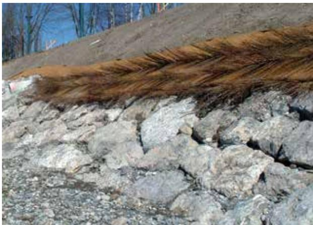
Fig. 37 - Fin de la mise en place des lits de plants et plançons (aménagement de type A).
