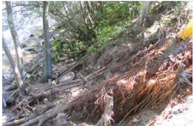
**Fig. 19** - Branches et leurs racines mises à nu artificiellement sur un ouvrage de type couches de branches, 15 ans après sa mise en place.
