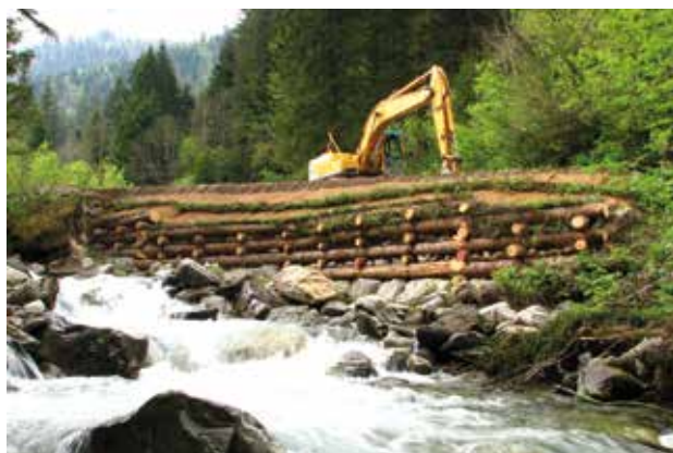
Fig. 6 - Caisson végétalisé en rivière de montagne sur le Bens (Isère - France).
