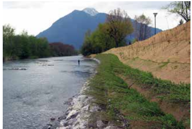
Fig. 38 - L'ouvrage à la fin des travaux (aménagement de type A).
