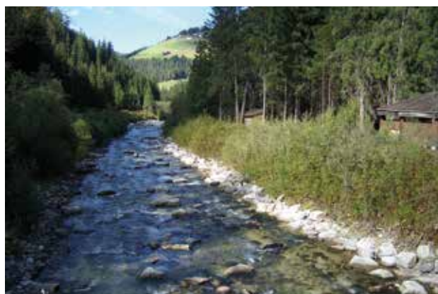
Fig. 6 - Exemple de technique végétale appliquée aux berges de rivières de montagne (Sud Tyrol - Italie).
