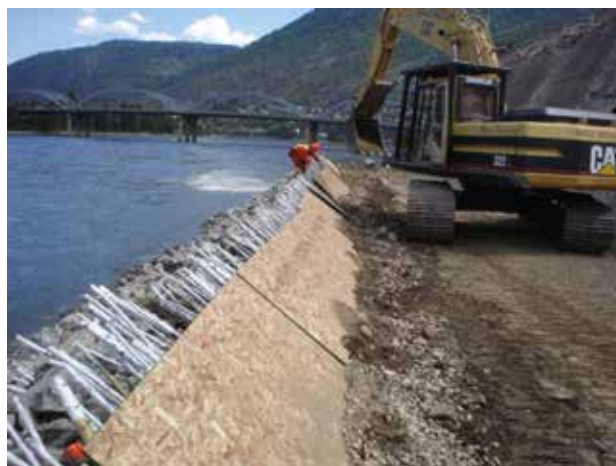
Fig. 80 - Positionnement des enrochements sur la partie supérieure.
