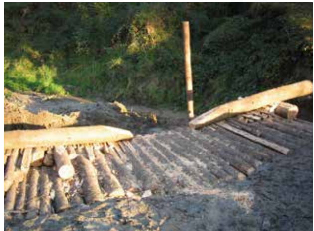
Fig. 29 - Barrage dont les ailes sont réalisées avec deux simples rondins de bois.
