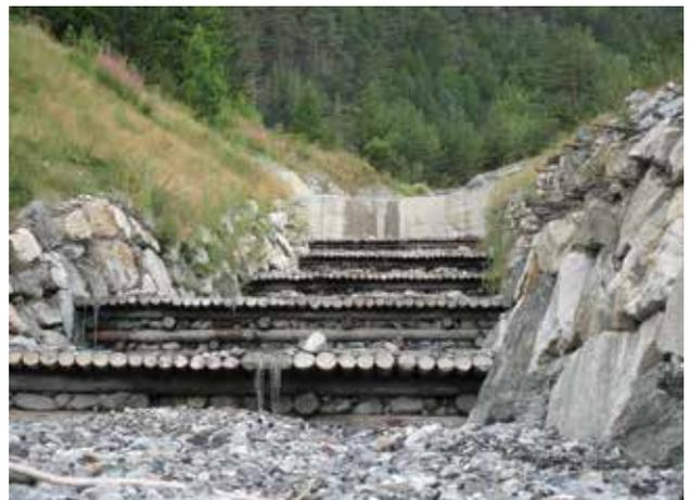
Fig. 34 - Barrage avec platelage en rondins entiers (haute vallée de Suze - Piémont - Italie).
