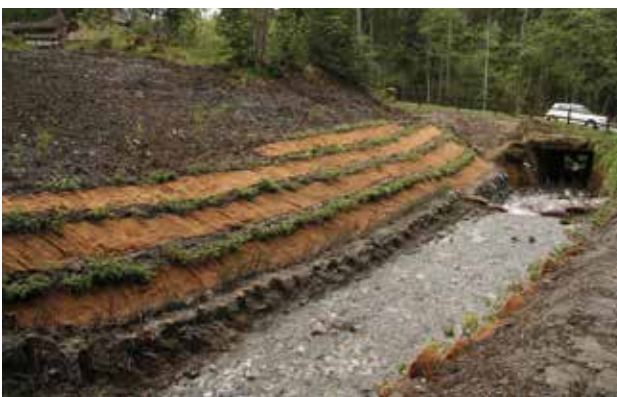
Fig. 17 - Fascine pour la protection du pied de berge surmontée de lits de plants et plançons.
