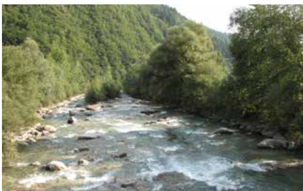
Fig. 2 - Ouvrage de protection de berge utilisant la technique des couches de branches à rejets sur la rivière Passer (Sud Tyrol - Italie), 20 ans après réalisation.
