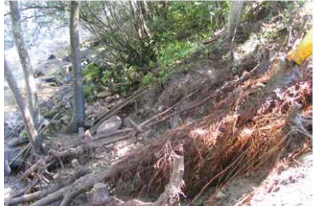
Fig. 19 - Branches et leurs racines mises à nu artificiellement sur un ouvrage de type couches de branches, 15 ans après sa mise en place.
