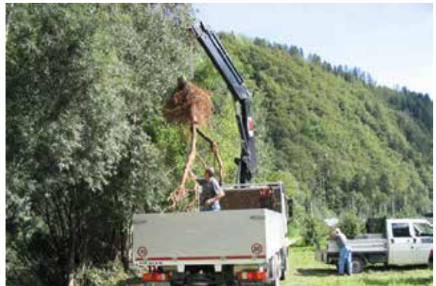
Fig. 21 - Extraction d'une branche des couches de branches à rejets, avec ses racines, 15 ans après sa mise en place.
