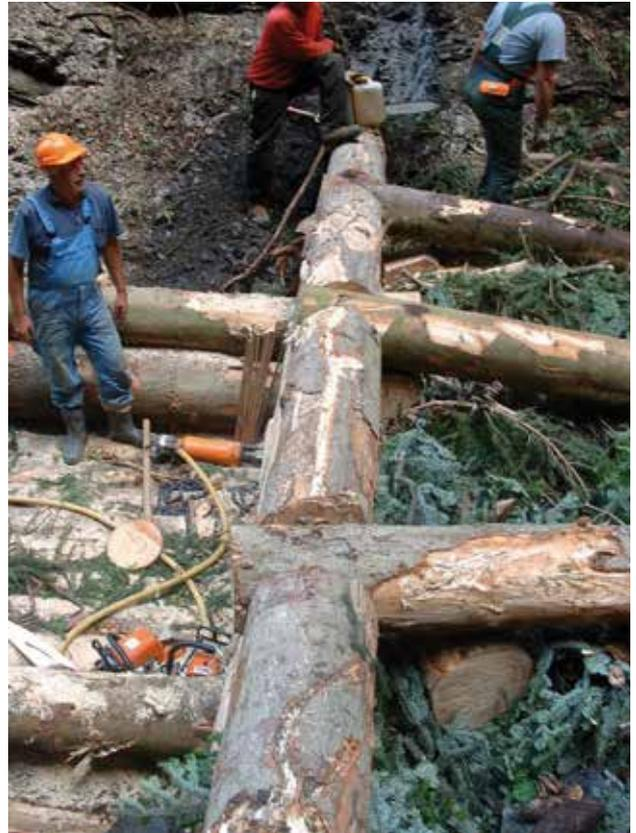
Fig. 45 - Montage d'un barrage à simple paroi avec tirants d'ancrage.
