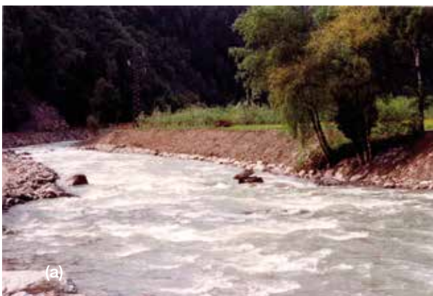
Fig. 17 - Vue générale de l'ouvrage de couches de branches à rejets avec enrochement en pied de berge, sur la rive droite de la rivière Passer à Rifiano : (a) situation à la fin des travaux en 1992 ; (b) état en 2011.
