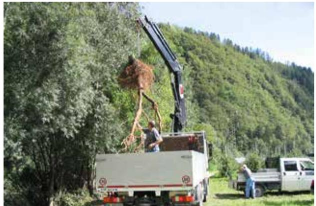
**Fig. 21** - Extraction d'une branche des couches de branches à rejets, avec ses racines, 15 ans après sa mise en place.
