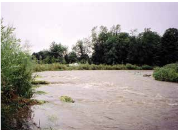
Fig. 65 - La berge de l'Adour deux ans après les travaux. En période de hautes eaux, les épis sont immergés.
