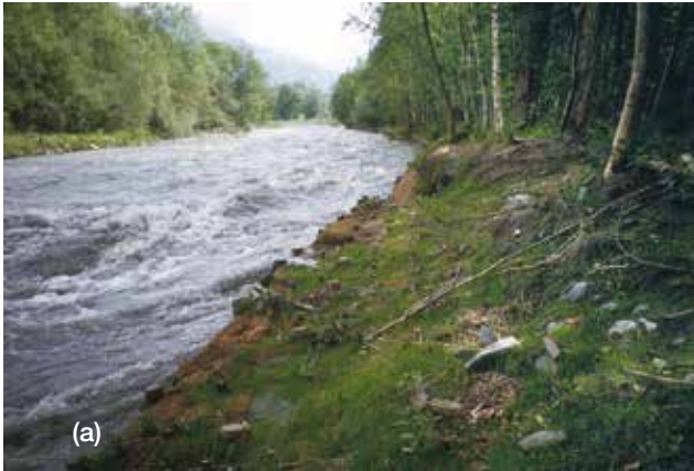
Fig. 16 - Ouvrage de génie végétal à Bourg-Saint-Maurice : (a) en 1996 ; (b) en 2011. Si la fascine inférieure est immergée et n'a pas repris, des arbres se sont développés à partir de la fascine supérieure.
