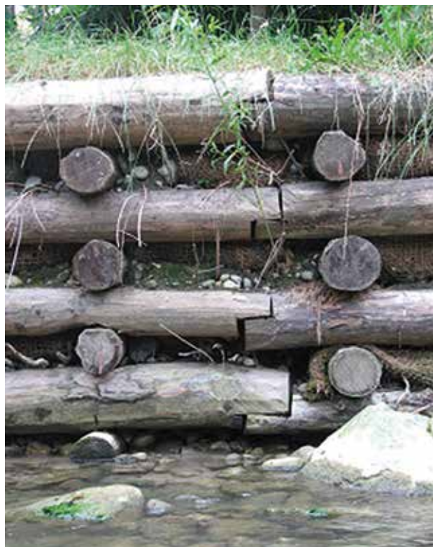
Fig. 42 - Montage des assemblages à proscrire.
