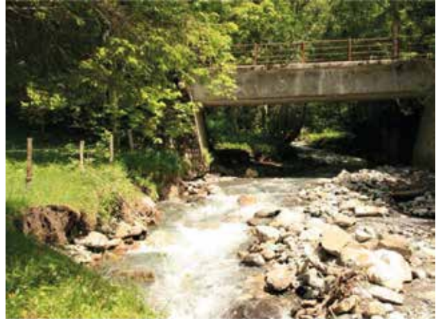
Fig. 24 - Le site à l'aval du pont lors de l'état des lieux.
