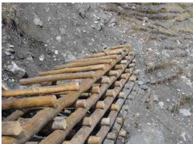
Fig. 17 - Ouvrage caisson à doubles parois.
