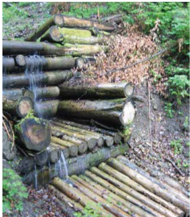
Fig. 43 - Barrage à simple paroi avec dispositif anti-affouillement.
