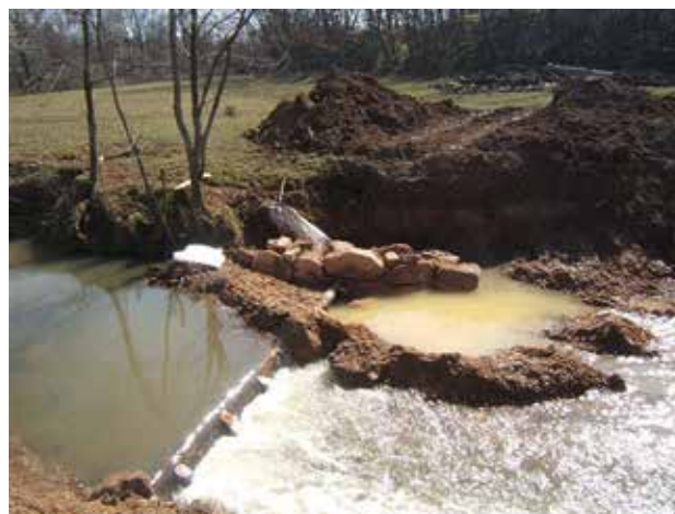
Fig. 8 - Calage de l'ouvrage en berge rive gauche par des enrochements.
