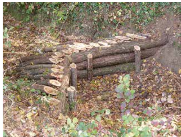
Fig. 14 - Seuil en « V » dans une ravine.
