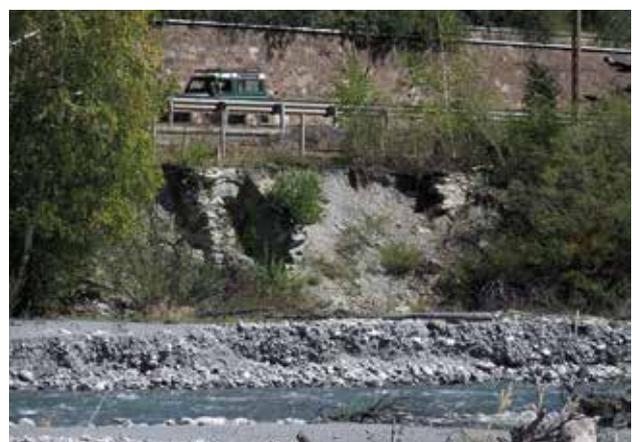
Fig. 3 - Érosion de berge menaçant plusieurs enjeux socio-économiques sur la Dora di Bardonecchia (Piémont - Italie) : route, chemin de fer, réseau électrique.
