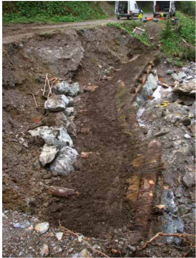
Fig. 49 - MISE EN PLACE DES PLANÇONS ET PLANTS DANS LE CAISSON.
