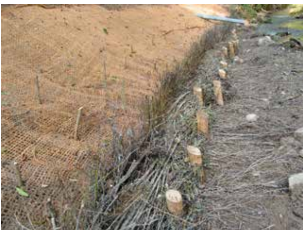
Fig. 8 - Détail de la fascine avec les branches anti-affouillement.
