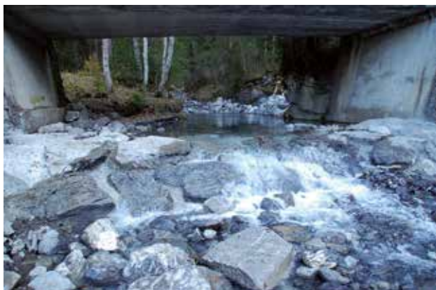
Fig. 29 - Seuil en enrochement bétonné à l'aval du pont.
