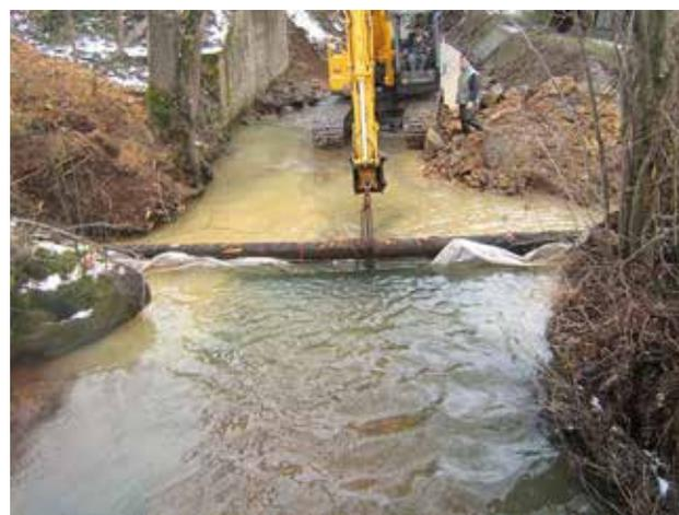
Fig. 9 - Installation d'un seuil préfabriqué à la pelle mécanique.
