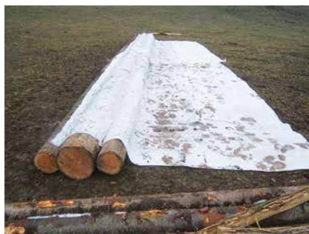
Fig. 7 - Assemblage et préfabrication d'un seuil à partir de grumes en épicéa.
