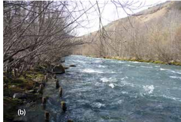
Fig. 16 - Ouvrage de génie végétal à Bourg-Saint-Maurice : (a) en 1996 ; (b) en 2011. Si la fascine inférieure est immergée et n'a pas repris, des arbres se sont développés à partir de la fascine supérieure.
