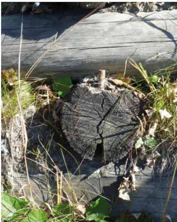
Fig. 41 - Assemblage par broche métallique en cours de dégradation par pourrissement du bois.
