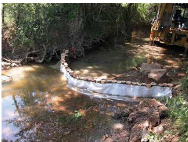
Fig. 13 - Installation d'un géotextile à l'amont du parement.
