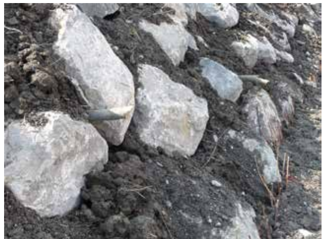
Fig. 76 - Mise en place de l'enrochement végétalisé en février 2011.
