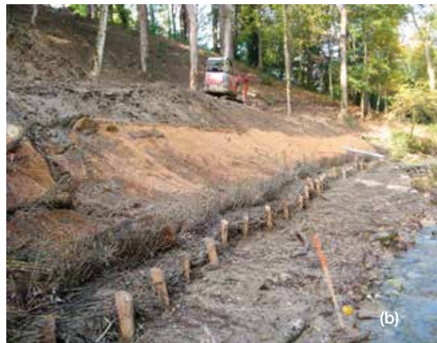
Fig. 7 - Partie aval du chantier : (a) avant travaux, la berge érodée retient les embâcles ; (b) pendant les travaux, mise en œuvre de la fascine vive et bouturage de la berge.
