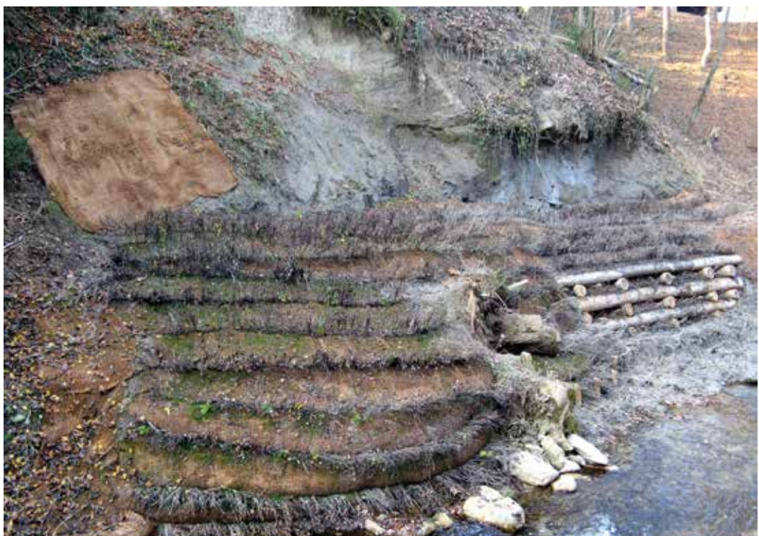
Fig. 6 - Le site après travaux : le premier lit de plançon en pied de berge et le caractère « fluide » des matériaux sont visibles.
