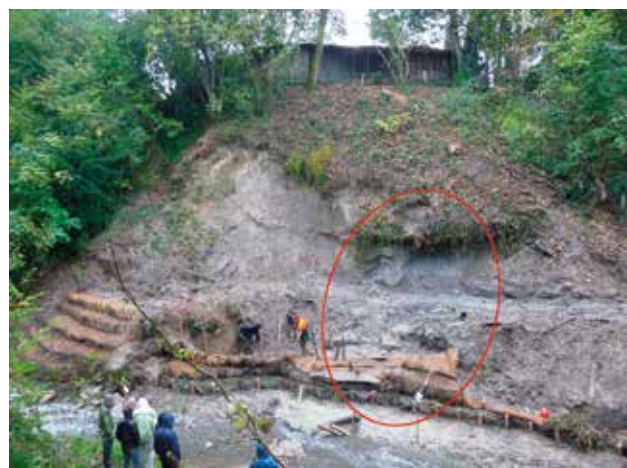
Fig. 9 - Mise en place d'un caisson végétalisé pour maintenir la poche d'argile.
