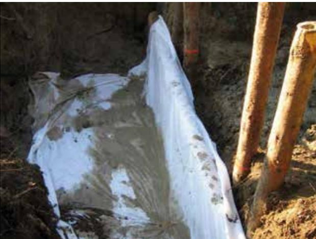
Fig. 4 - Installation d'un géotextile contre le parement amont de l'ouvrage.
