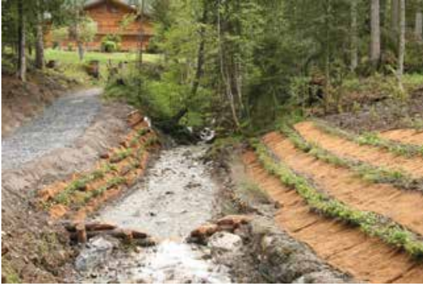
Fig. 21 - Seuil en rondins pour stabiliser le profil en long. À droite, passage à un enrochement de pied de berge à l'aval du seuil.
