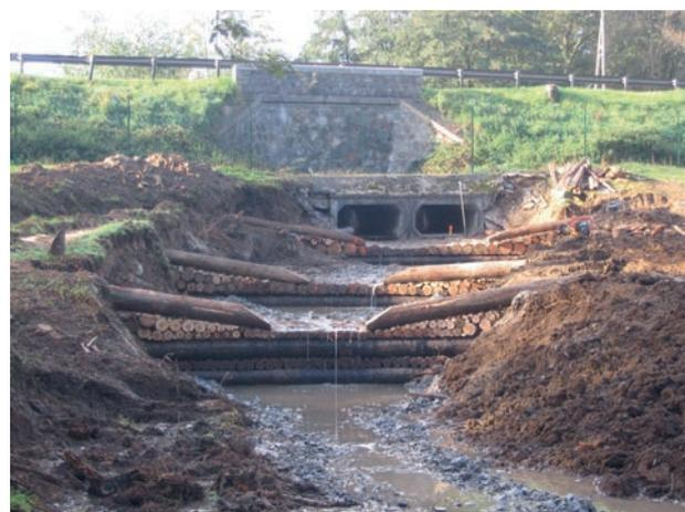
Fig. 24 - Barrage à doubles parois avec parement réalisé en rondins disposés parallèlement aux traverses.
