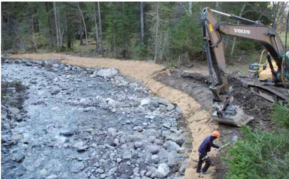
Fig. 28 - Lit de plants et plançons en cours de réalisation. Dans le lit, les deux épis en enrochement sont visibles.
