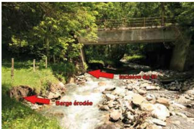
Fig. 4 - Érosion de la berge et incision du lit mettant en danger le pont.
