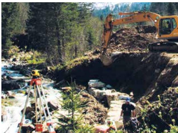
**Fig. 46** - Construction du support du caisson en enrochement.
