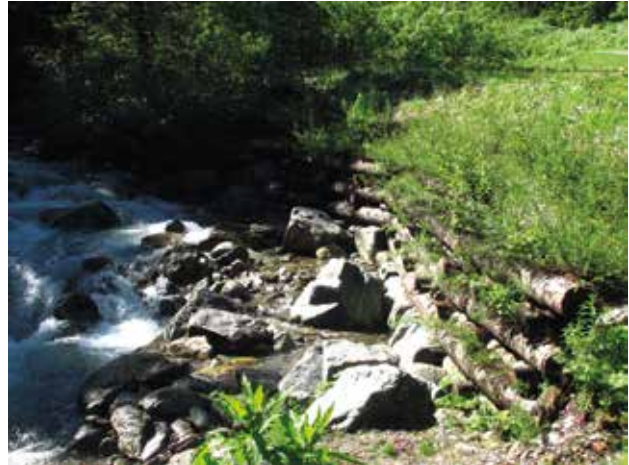
Fig. 53 - L'ouvrage après une saison de végétation.
