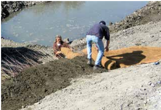
Fig. 36 - Le géotextile est déroulé sur le premier lit de plants et plançons.
