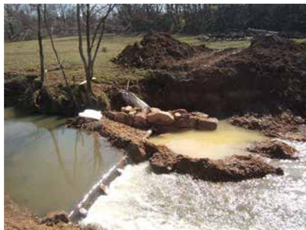
Fig. 8 - Calage de l'ouvrage en berge rive gauche par des enrochements.
