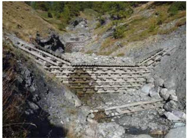
Fig. 28 - Barrage dont les ailes sont réalisées avec des longrines inclinées à 45° (Sestrières - Piémont - Italie).
