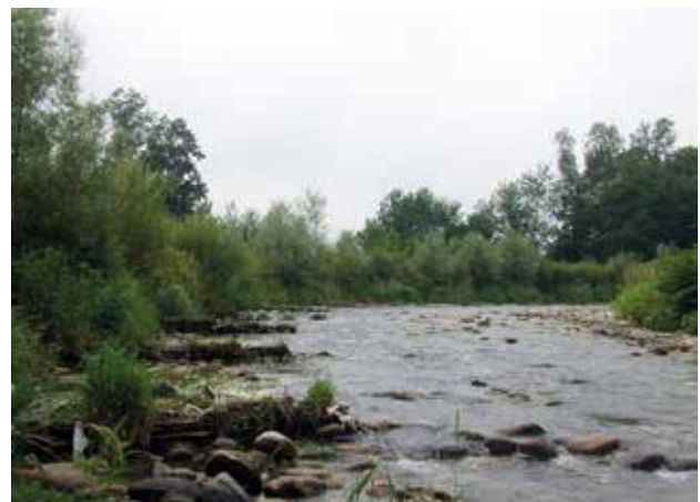
Fig. 66 - La berge de l'Adour quatre ans après les travaux. Les épis sont toujours visibles.
