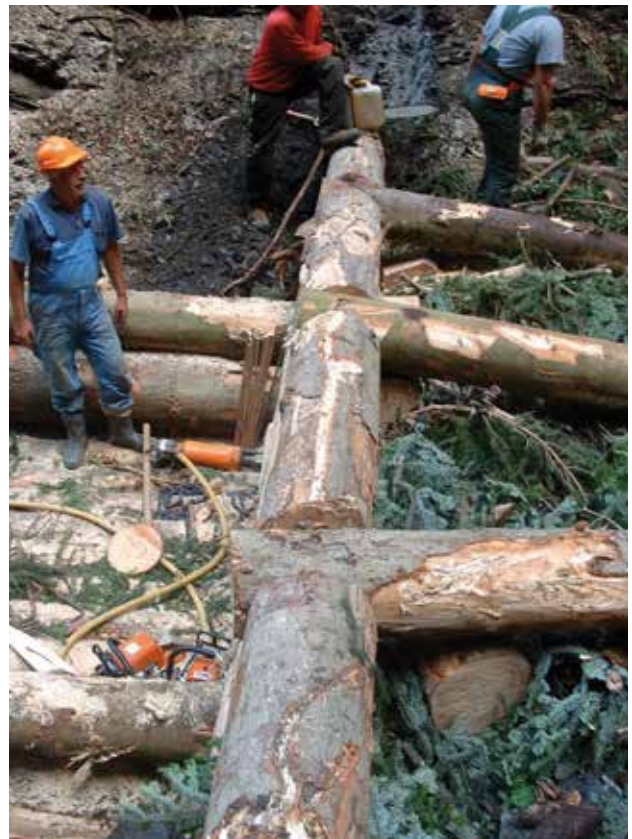
Fig. 45 - Montage d'un barrage à simple paroi avec tirants d'ancrage.
