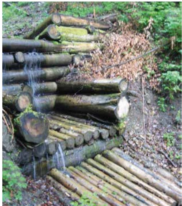
**Fig. 43** - Barrage à simple paroi avec dispositif anti-affouillement.
