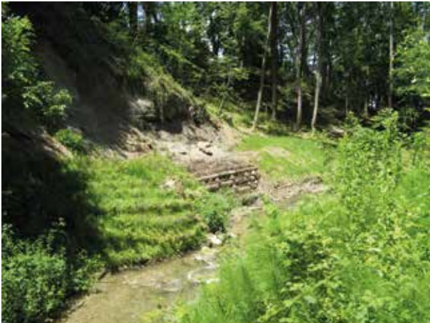
Fig. 12 - Vue de l'ouvrage au printemps suivant l'implantation.
