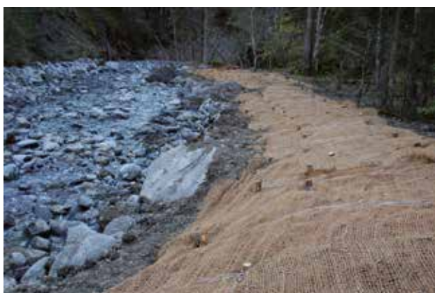
Fig. 30 - Détails sur l'enrochement de pied de berge et les couches de branches à rejets.
