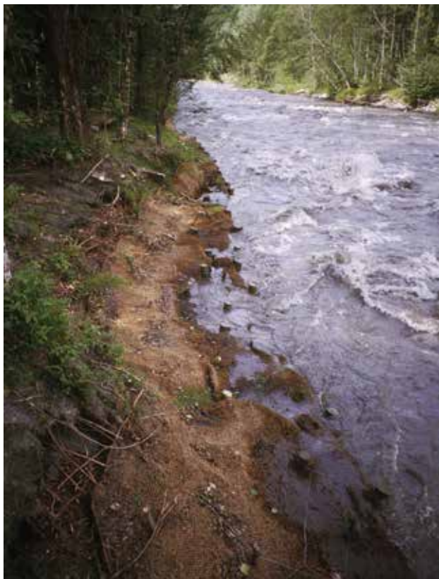
Fig. 10 - Ouvrage de génie végétal sur une rivière dynamique juste après sa mise en place.
