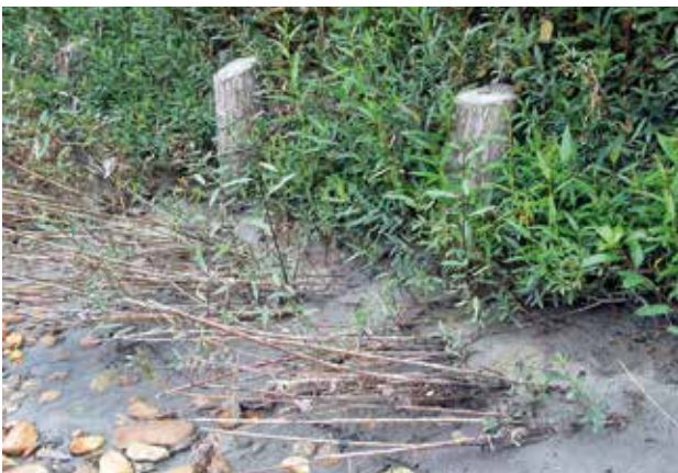
Fig. 11 - Piégeage des sédiments fins par les ramilles anti-affouillement, placées ici sous un ouvrage de protection de pied de berge, perpendiculairement au courant.
