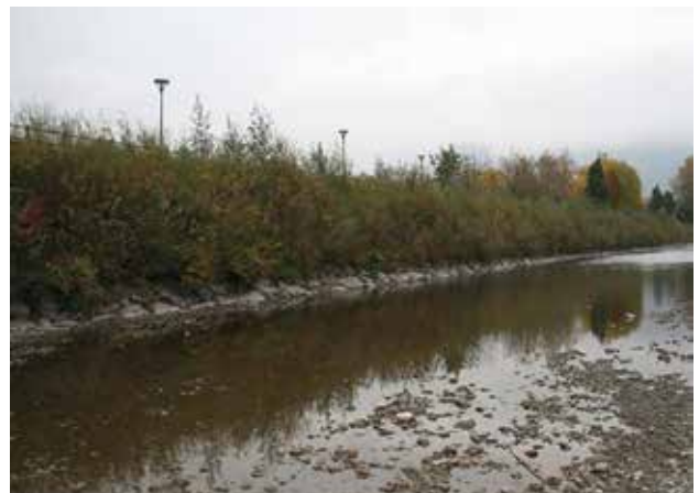
Fig. 39 - L'ouvrage trois ans après la fin des travaux.
