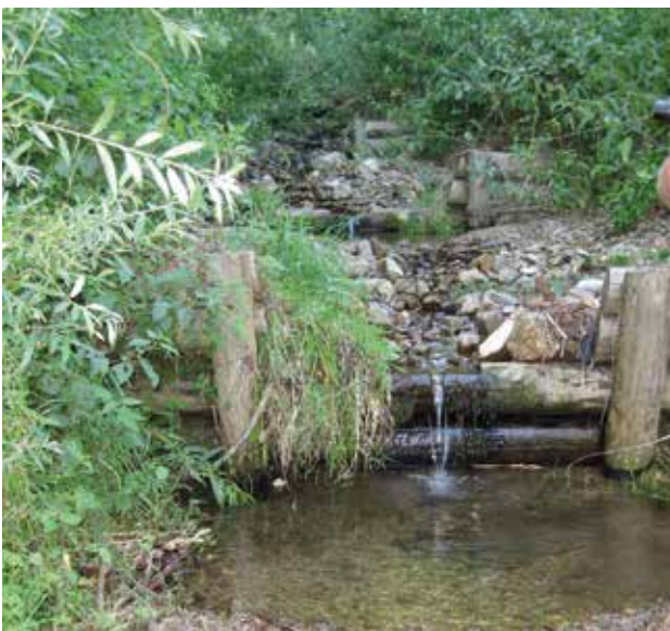
Fig. 5 - Petits seuils rustiques en bois avec ailes fixées sur les pieux.
