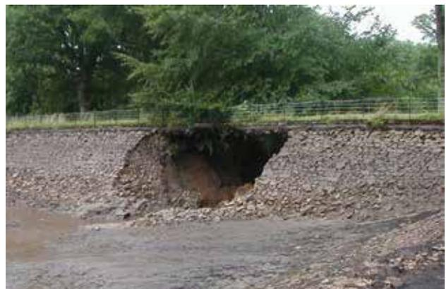
Fig. 6 - Conséquences d'un renard hydraulique sur le barrage des Ouches (Puy-de-Dôme - France).
