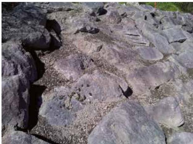
Fig. 73 - L'enrochement après le comblement des vides.
