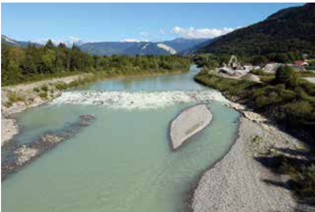
Fig. 70 - Vue aérienne du seuil, depuis l'aval, en septembre 2011.
