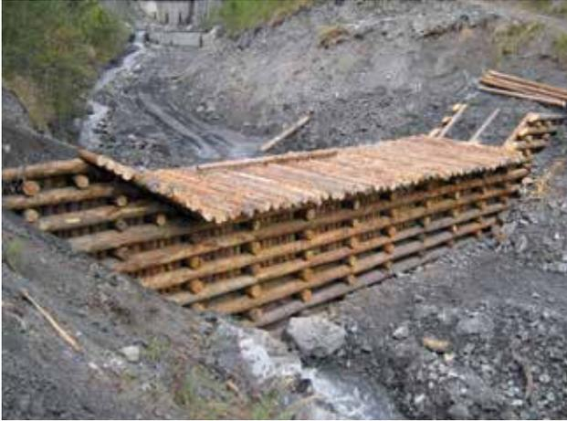
Fig. 25 - Barrage à doubles parois avec parement réalisé avec des bois verticaux.
