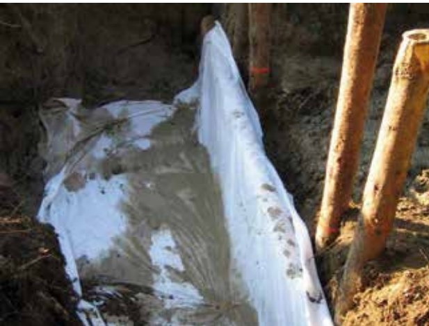
Fig. 4 - Installation d'un géotextile contre le parement amont de l'ouvrage.
