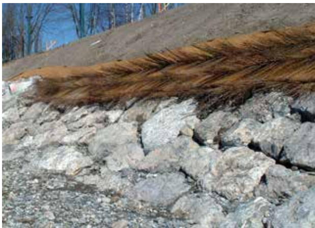
Fig. 37 - Fin de la mise en place des lits de plants et plançons (aménagement de type A).
