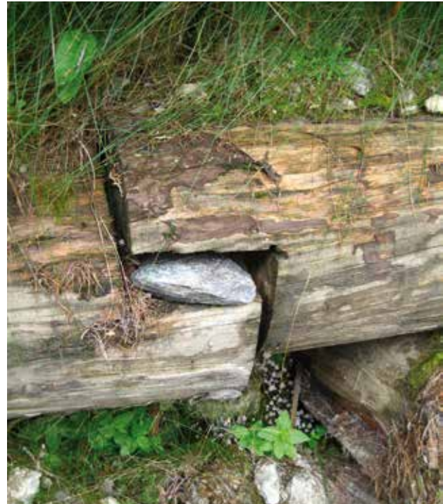
Fig. 37 - Assemblage de deux longrines par une coupe à mi-bois.
