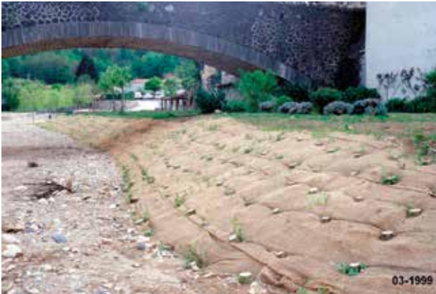
Fig. 55 - L'ouvrage en mars 1999 après réalisation.
