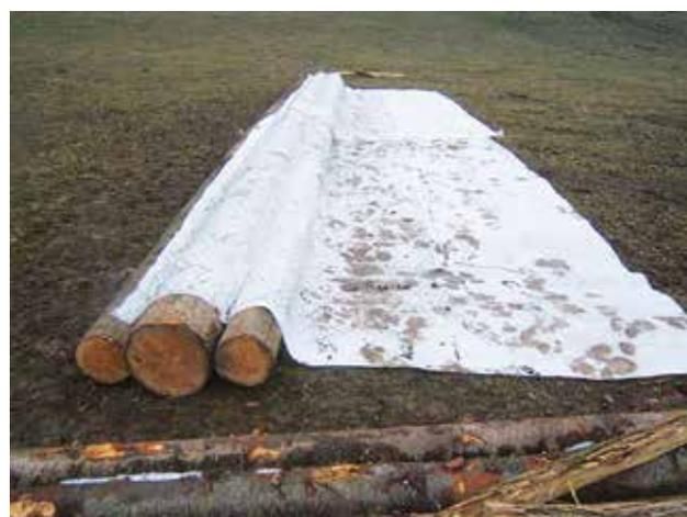
Fig. 7 - Assemblage et préfabrication d'un seuil à partir de grumes en épicéa.
