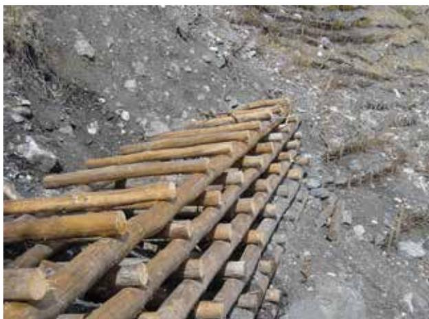
Fig. 17 - Ouvrage caisson à doubles parois.
