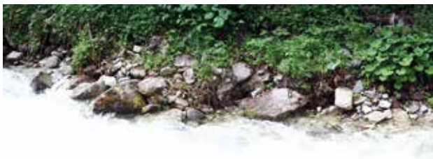
Fig. 9 - Exemple d'un enrochement naturel en pied de berge d'un torrent.
