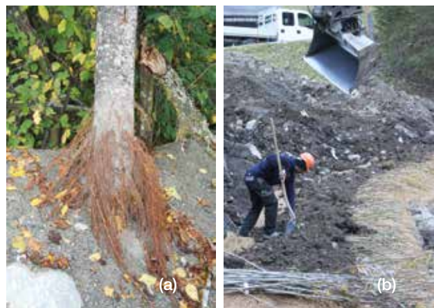
Fig. 4 - Certaines espèces présentent une capacité naturelle à former des racines adventives, (a) à l'image de cet aulne blanc ( Alnus incana ). Cette propriété est particulièrement adaptée pour les techniques où les végétaux sont partiellement enfouis dans le substrat, (b) à l'exemple des lits de plants et plançons.
