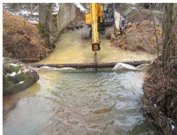
Fig. 9 - Installation d'un seuil préfabriqué à la pelle mécanique.
