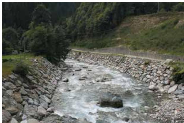
Fig. 5 - Enrochement de berge en rivière de montagne.
