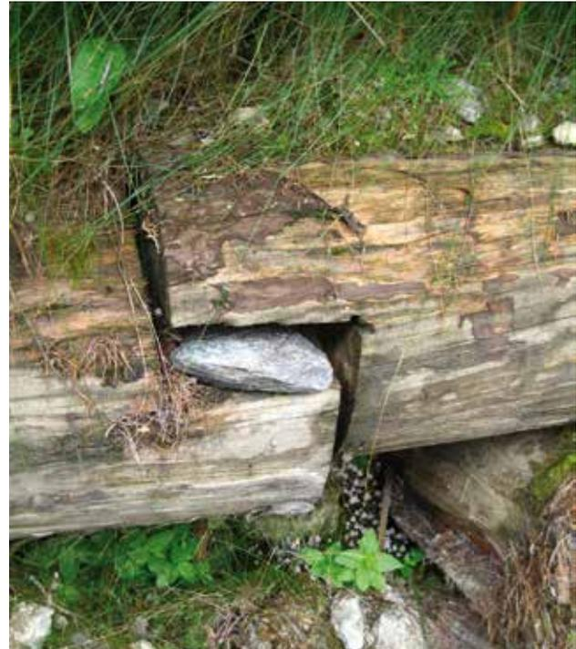
Fig. 37 - Assemblage de deux longrines par une coupe à mi-bois.
