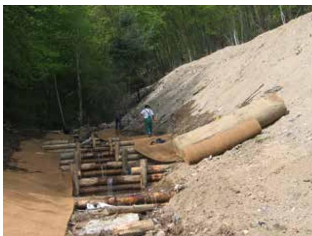
Fig. 1 - Succession de petits seuils à simple paroi réalisés dans le cours d'eau Artilla (Rhône - France).
