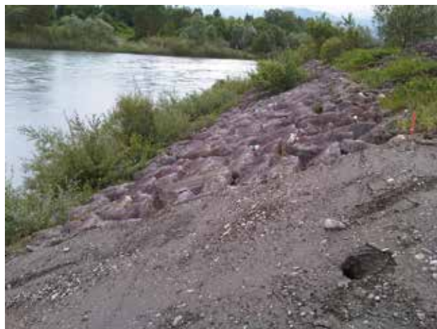
Fig. 75 - Vue sur l'enrochement avec une partie plaquée et l'autre nue.
