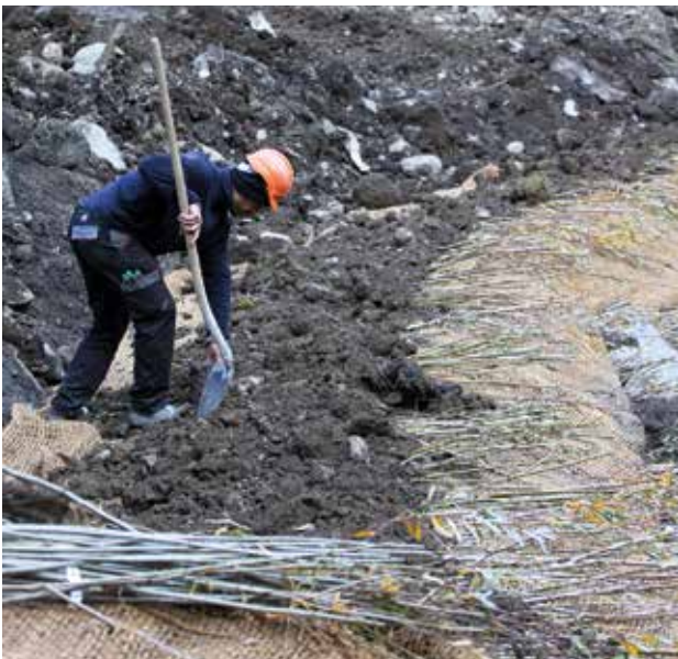
Fig. 1 - Mise en place des plançons de saule sur un des chantiers pilotes de Géni'Alp.
