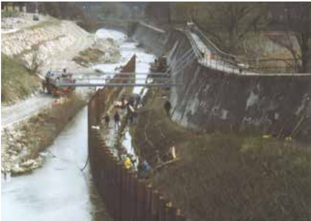
Fig. 10 - Canal de test de l'Institut für Ingenieurbiologie und Landschaftbau.
