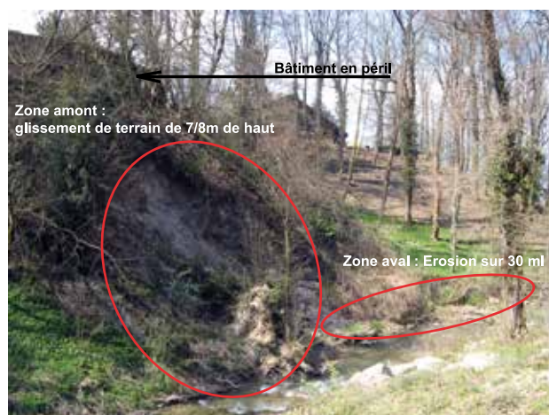
Fig. 3 - État des lieux avant intervention.
