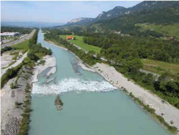
Fig. 69 - Vue aérienne du seuil, depuis l'amont, en septembre 2010. La berge de gauche est orientée nord et celle de droite est orientée sud. L'impact paysager et la discontinuité du corridor alluvial apparaissent clairement.
