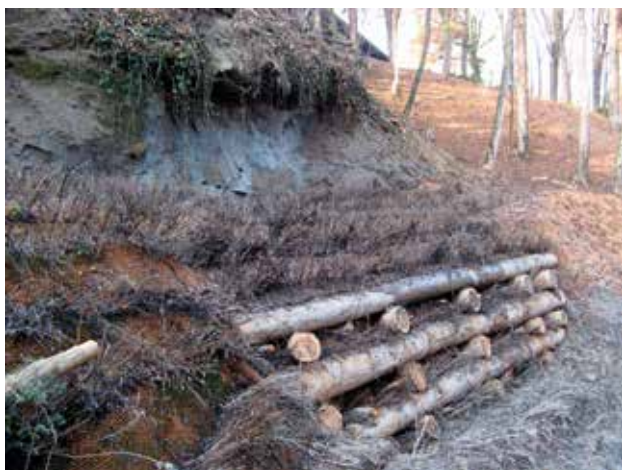
Fig. 11 - Chantier terminé au droit de la poche d'argile.
