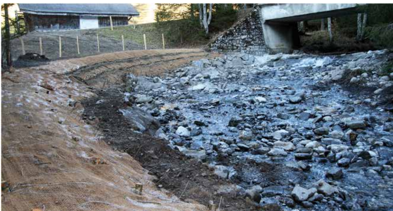
Fig. 32 - Vue générale de l'aménagement en fin de chantier.
