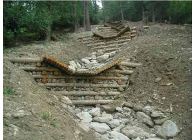
Fig. 22 - Barrage comprenant une cuvette avec parement en pierres à la Norma (Savoie - France).
