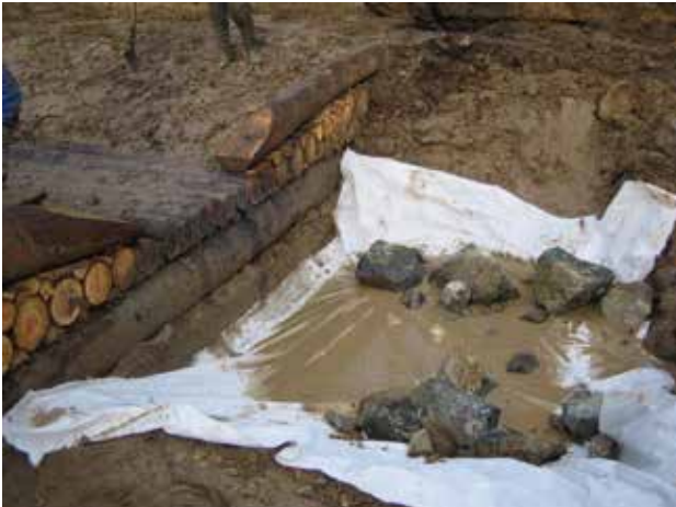
Fig. 36 - Création d'une fosse de dissipation de l'énergie hydraulique en pied d'un caisson bois.
