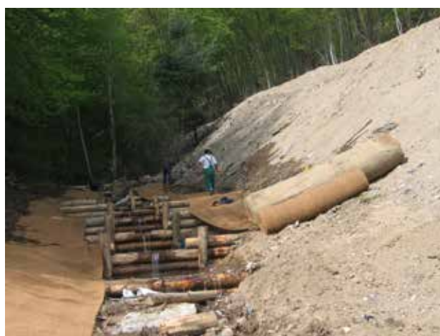
Fig. 1 - Succession de petits seuils à simple paroi réalisés dans le cours d'eau Artilla (Rhône - France).
