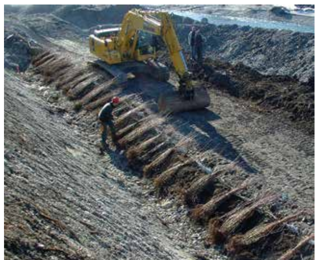
Fig. 34 - Mise en place des plants sur le premier lit de plants et plançons au début du printemps 2005.
