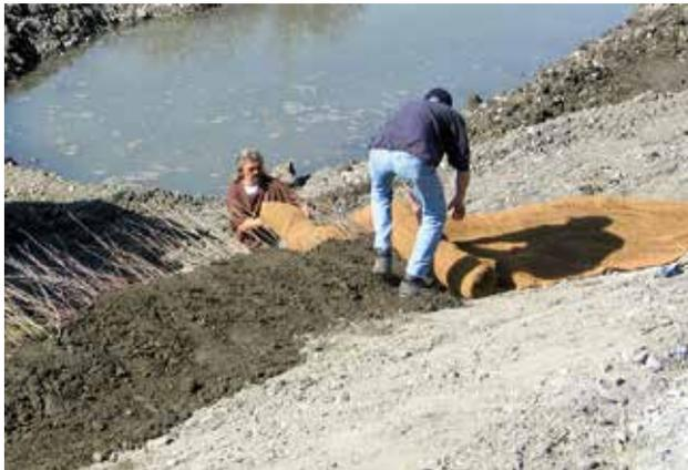
Fig. 36 - Le géotextile est déroulé sur le premier lit de plants et plançons.
