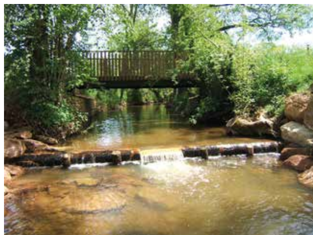
Fig. 6 - Petit seuil rustique avec dispositif de recalibrage des débits.
