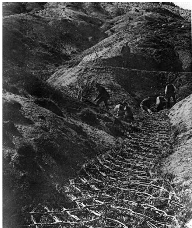
Fig. 1 - Garnissage d'un ravin par la technique de clayonnage en croisillons, services de restauration et conservation des terrains en montagne (1911).
