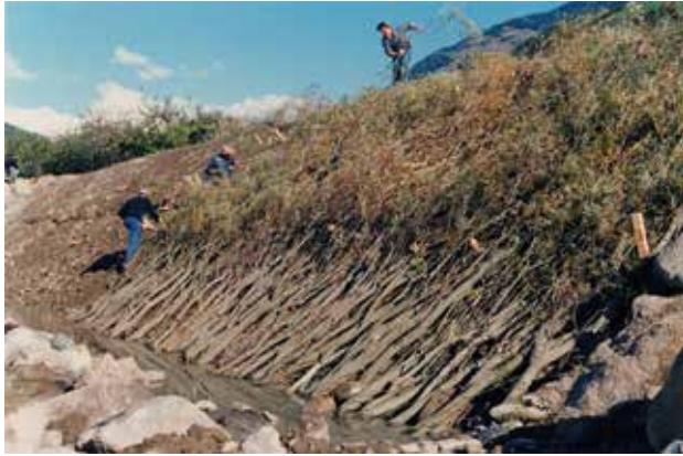
Fig. 18 - Mise en place de couches de branches à rejets.
