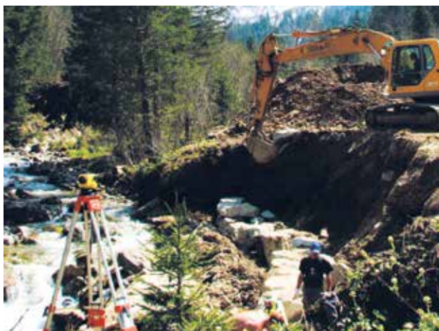
Fig. 46 - Construction du support du caisson en enrochement.
