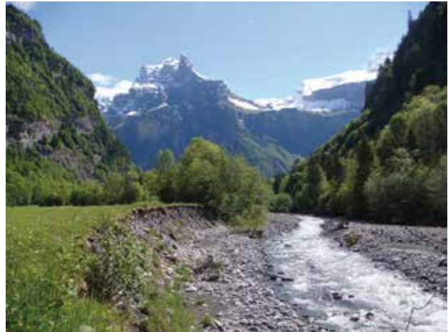
Fig. 1 - Érosion de berge sur le Haut Giffre (Haute-Savoie - France).
