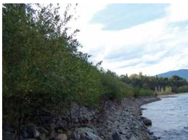
Fig. 81 - L'ouvrage 4 ans après les travaux.
