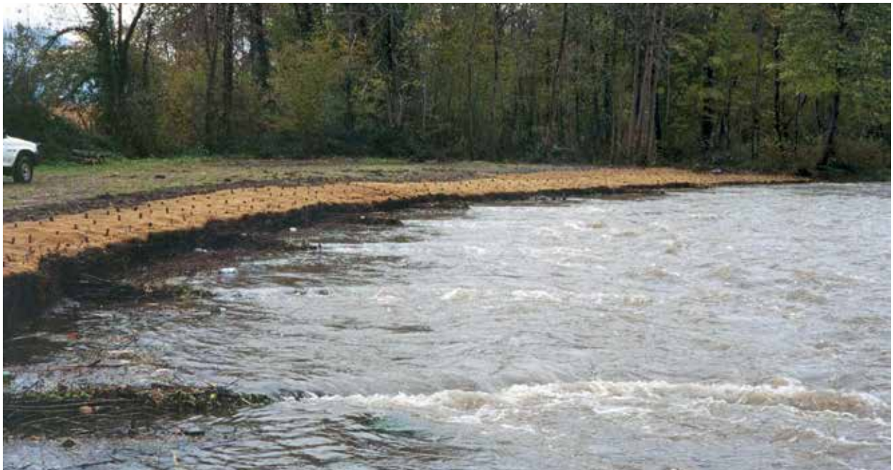
Fig. 64 - La berge de l'Adour juste après les travaux (automne 1999). L'effet des épis sur le courant est perceptible.
