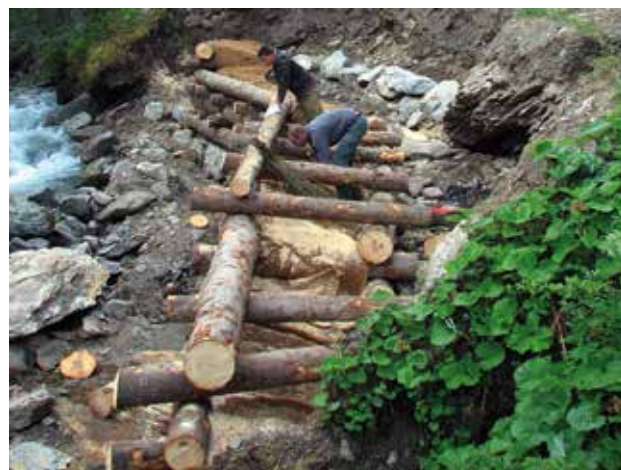
Fig. 47 - L'ossature de l'ouvrage, avec les longrines parallèles au cours d'eau et les moises perpendiculaires.
