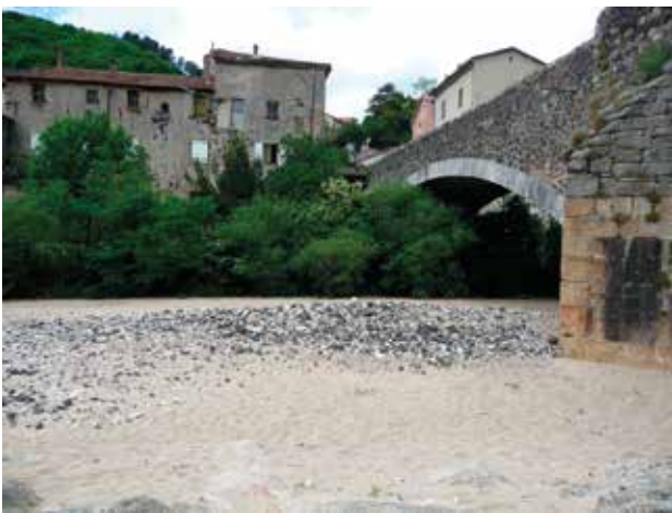
Fig. 56 - L'ouvrage en mai 2011. La végétation s'est généreusement implantée.
