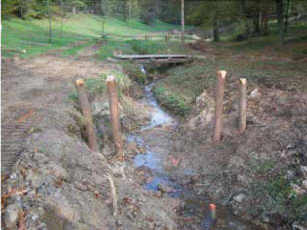
Fig. 3 - Installation des pieux d'un seuil bois classique.
