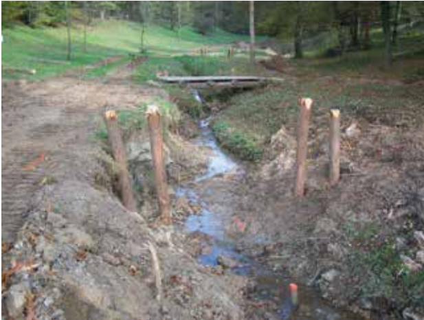
Fig. 3 - Installation des pieux d'un seuil bois classique.
