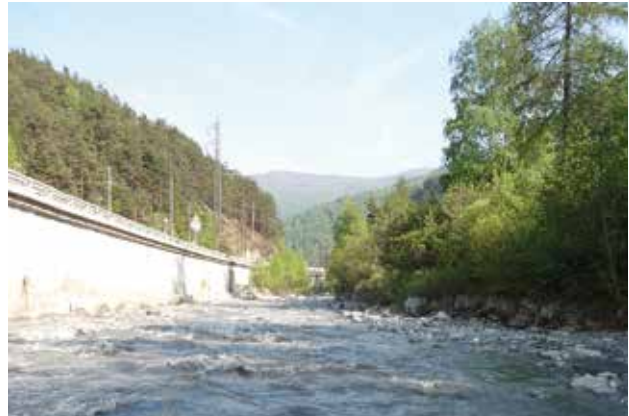
Fig. 41 - Vue générale au niveau de l'aménagement.
