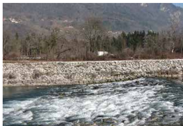
Fig. 68 - Vue de la berge sud de l'Arve au niveau du seuil de Vougy-Marignier. État de l'enrochement avant les travaux de végétalisation.
