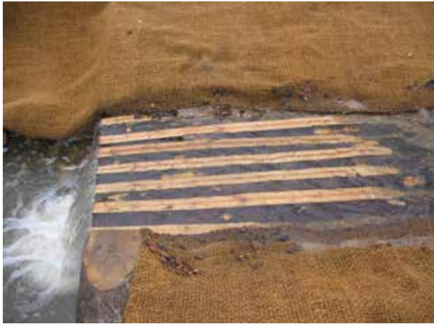
Fig. 30 - Barrage avec platelage en bois refendus sur la longueur.
