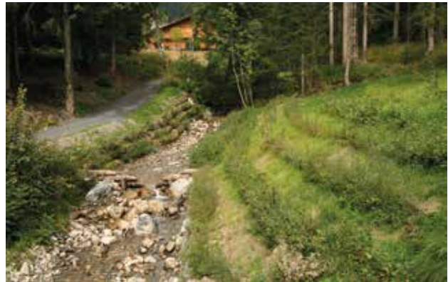
Fig. 1 - Protections de berges en génie végétal sur la Petite Gryonne, cours d'eau torrentiel des Préalpes vaudoises (chantier pilote Géni'Alp - Canton de Vaud - Suisse).
