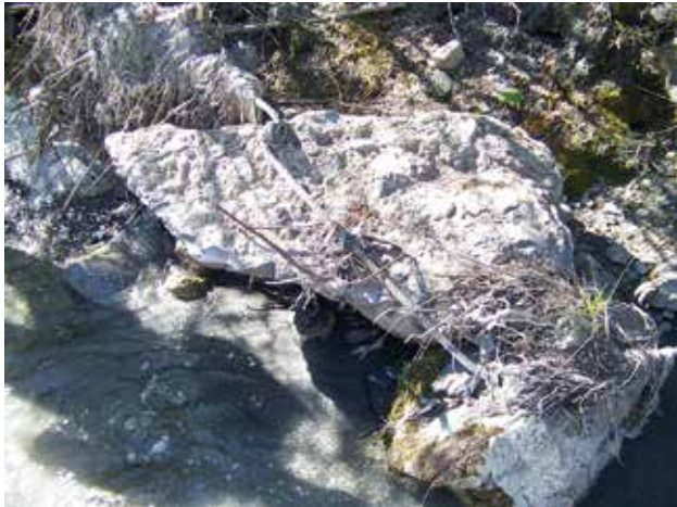
Fig. 42 - L'observation de la fixation du câble montre que le bloc a tourné sur lui-même au cours d'une crue.
