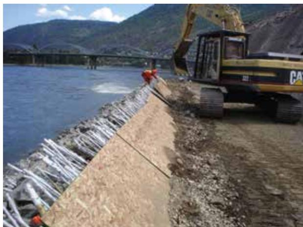
Fig. 80 - Positionnement des enrochements sur la partie supérieure.
