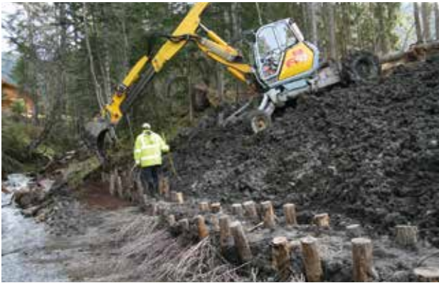
Fig. 16 - Fascine à double rangée de pieux en cours de réalisation.
