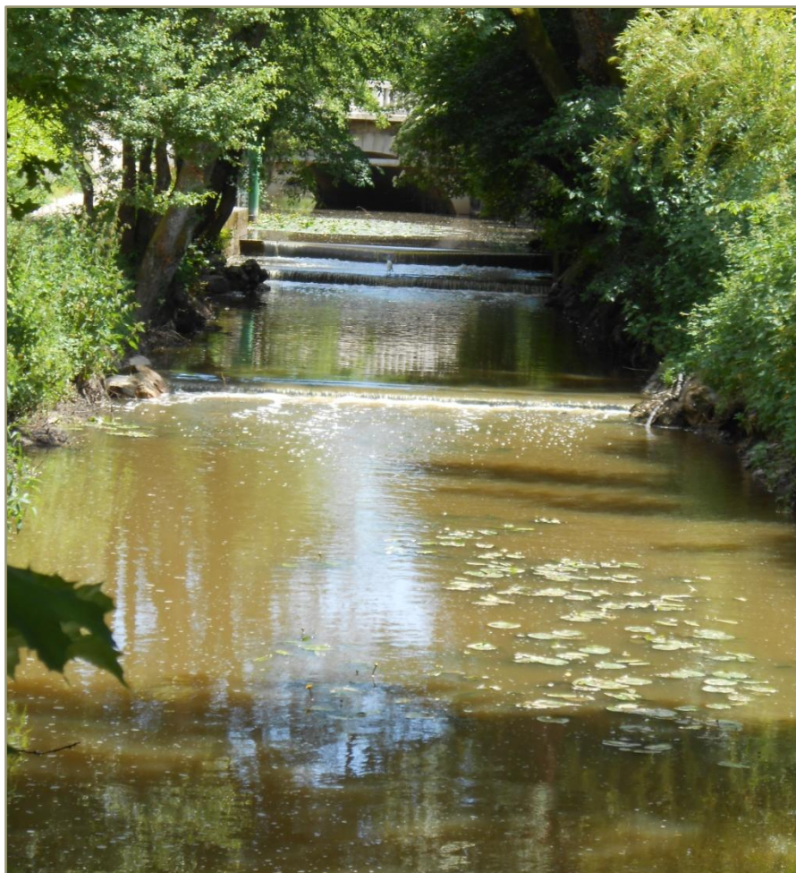
Figure 5 : Enchaînement de seuils sur la Chalaronne à Villars-les-Dombes - Source : Honorine ROCHE, prise le 12/06/2013
