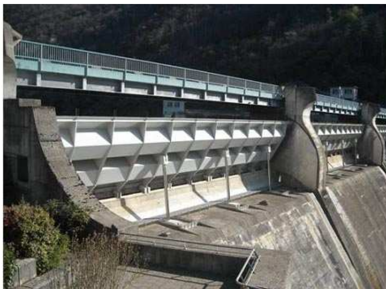
Photo 3.2 – Clapet, barrage de Pinet sur le Tarn
