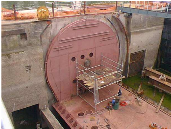
Ouverte (à sec, pendant la construction)
