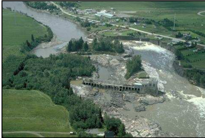
Photo 5.2 – Barrage de Chute Garneau – Chenal de contournement
