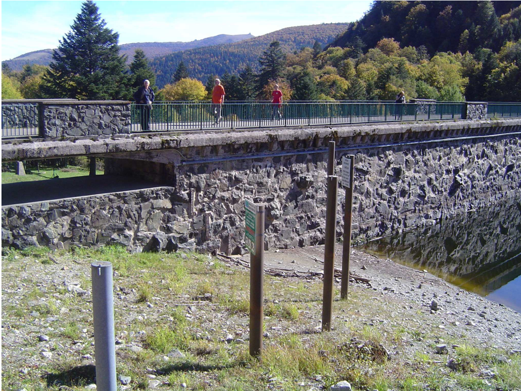
Photo 3.1 – "Peigne à flottants" en amont d'un évacuateur de section restreinte
