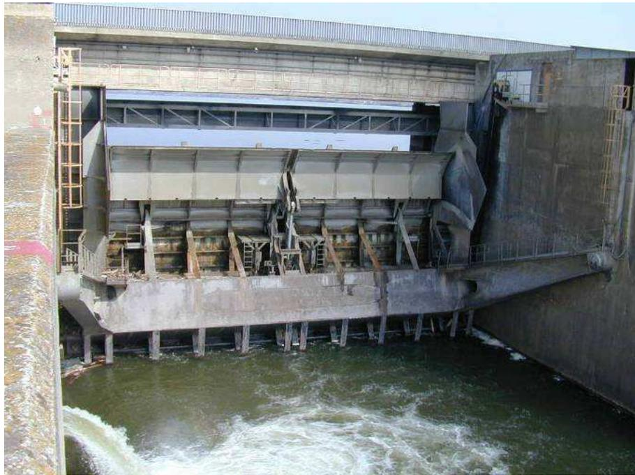
Photo 3.4 – Vanne segment munie d'un volet de surface, barrage de Caderousse
