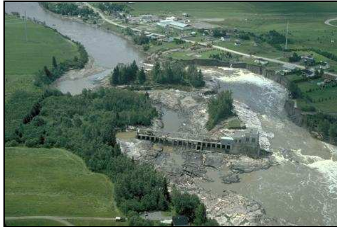
Photo 5.2 – Barrage de Chute Garneau – Chenal de contournement
