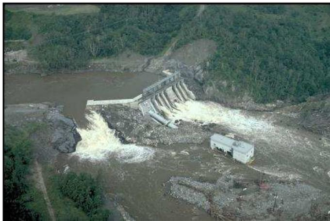
*Photo 5.1 – Brèche de 20 m dans le mur en aile du barrage de Jonquière*
