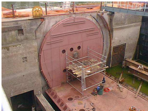
Ouverte (à sec, pendant la construction)
