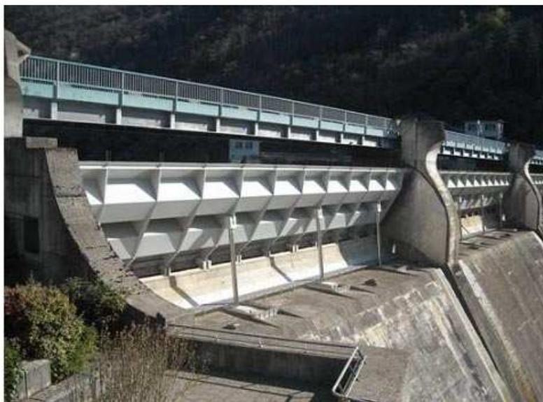
Photo 3.2 – Clapet, barrage de Pinet sur le Tarn
