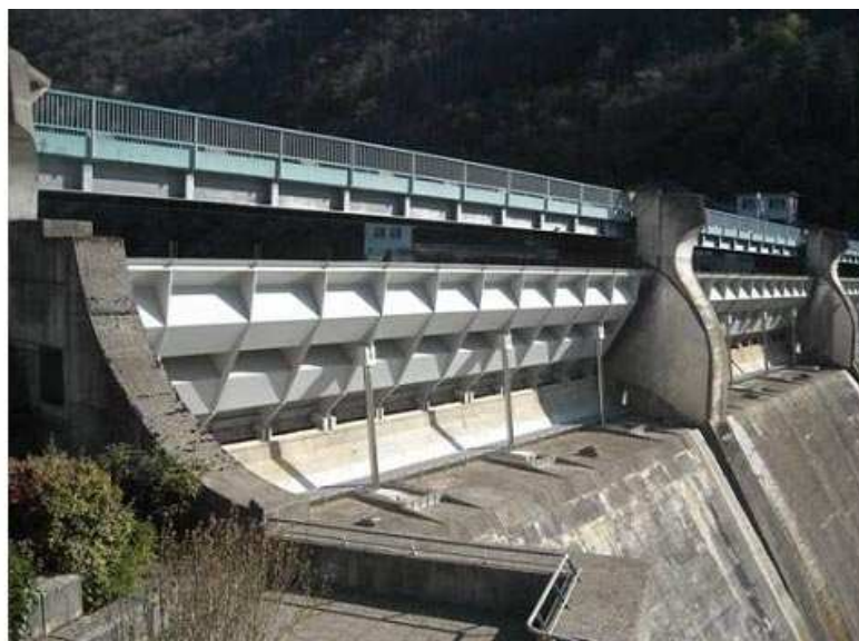
Photo 3.2 – Clapet, barrage de Pinet sur le Tarn
