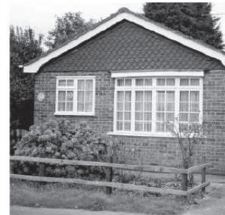
Figure 14. Vulnérabilité des bâtiments, cas 1, surface de 38 m 2 sans étage (source 8 : « Physical Flood Vulnerability of Residential Properties in Coastal, Eastern England »)
