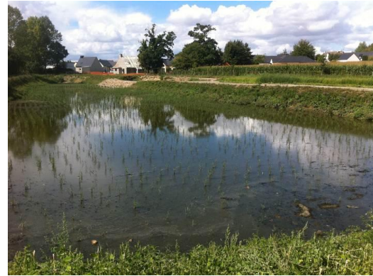
FIGURE 2: FILTRE PLANTE EN EAU, LAMBALLE (22) POUR LE TRAITEMENT DES EAUX PLUVIALES STRICTES (PHOTO SINBIO)
