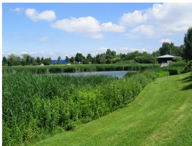
FIGURE 15 : PENDAGE DE TALUS 6/1. PORTE DES ALPES À SAINT PRIEST (GRAND LYON 2008)
