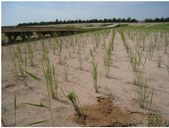
FIGURE 1: FILTRE PLANTÉ POUR LE TRAITEMENT DES EAUX PLUVIALES STRICTES – GARE TGV BEZANNES (51) (PHOTO SINBIO)
