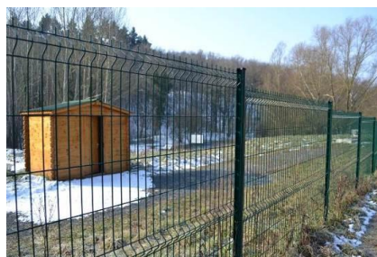
Type d'aménagement sur des ouvrages de gestion des RUTP 1112
