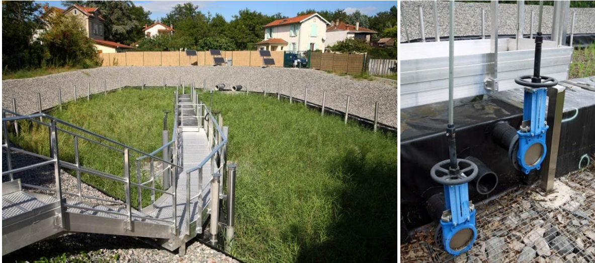
FIGURE 23 : PHOTOS DE LA SÉPARATION DU FILTRE (GAUCHE) ET DES DIFFÉRENTS NIVEAUX DE CONNEXION HYDRAULIQUE (DROITE) POUR LE SITE DE MARCY L'ÉTOILE (69)
