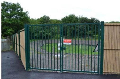
FIGURE 28 : ABSENCE DE DÉCHETS AUTOUR DU PROTOTYPE DE MARCY L'ÉTOILE (69), AS, 2012
