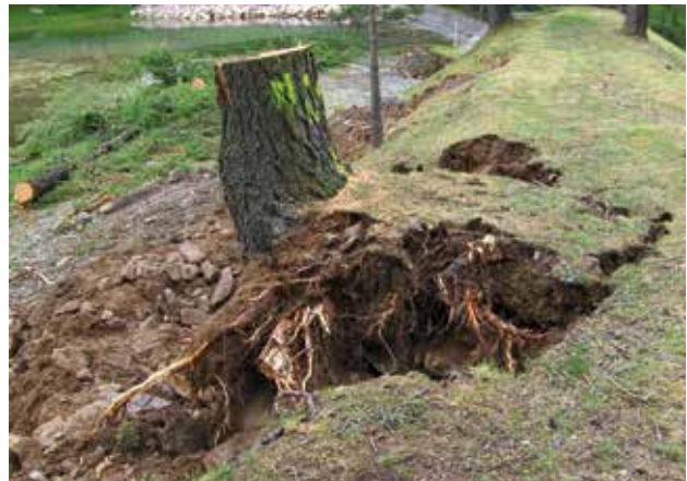
Fig. 9 - Arrachement par basculement d'une souche de mélèze.
