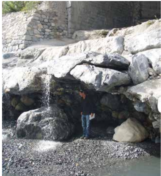
Fig. 2 - Déchaussement d'ouvrage latéral dû à l'incision du cours d'eau à la confluence du Claret avec l'Arc (Savoie - France).
