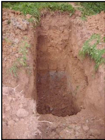
Fosse à la pelle mécanique, pendant l'étude géotechnique
