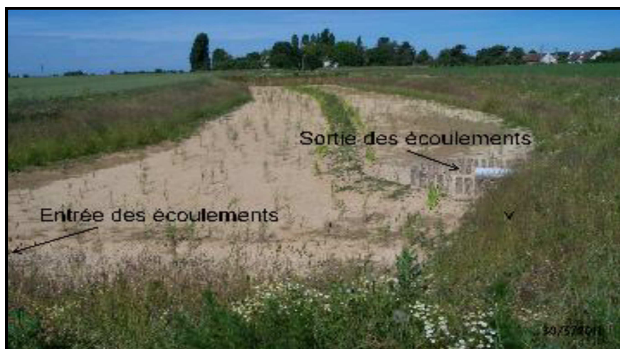
Bassin avec entrée et sortie proches mais séparées par une diguette centrale
