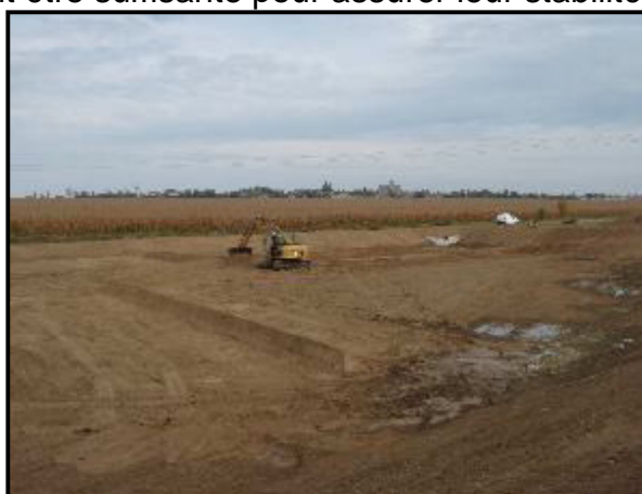
Mise en place des diguettes
