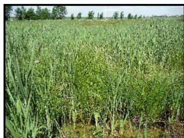
ZTHA de Rampillon végétalisée
