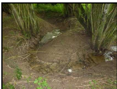
Zone d'engouffrement d'un fossé agricole
