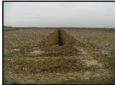
Tranchée creusée par une draineuse trancheuse
