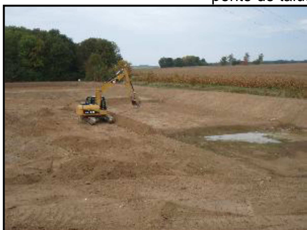
Mise en place des diguettes
