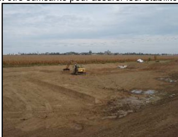
Mise en place des diguettes
