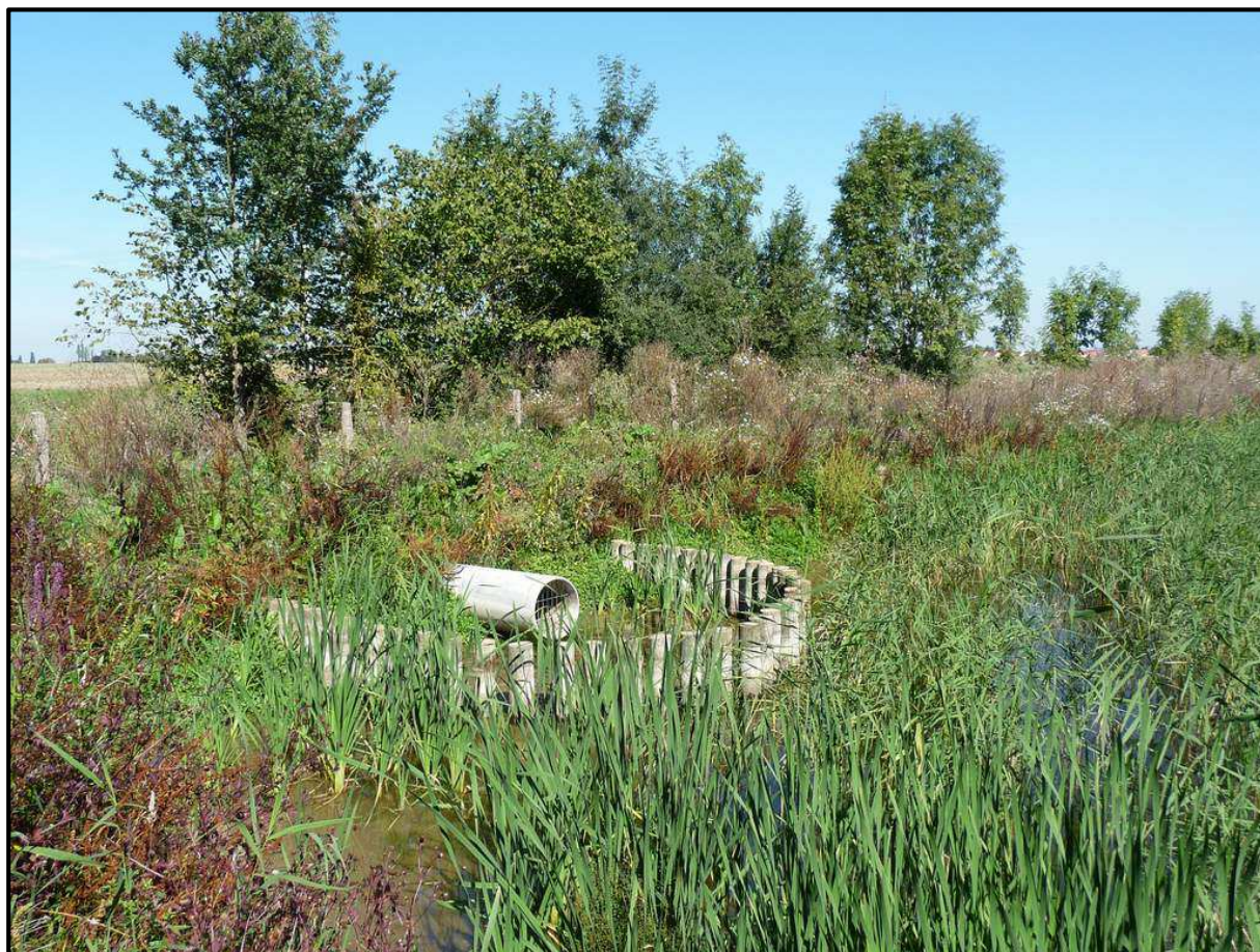
Exutoire de la ZTHA végétalisée de Rampillon
