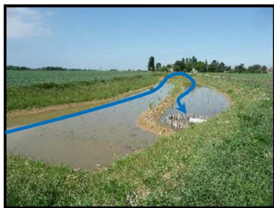
ZTHA en cours de végétalisation avec une diguette centrale
