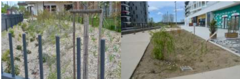
Figure 65 : Exemple de dispositif d'infiltration dans une parcelle privée (photo de droite), exemple de noe de stockage dans l'espace public (photo de gauche) – photos : S. Baati, 2013
