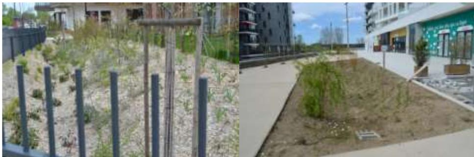
Figure 65 : Exemple de dispositif d'infiltration dans une parcelle privée (photo de droite), exemple de noue de stockage dans l'espace public (photo de gauche) – photos : S. Baati, 2013
