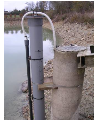
Figure 6 : Surverse du bassin.
