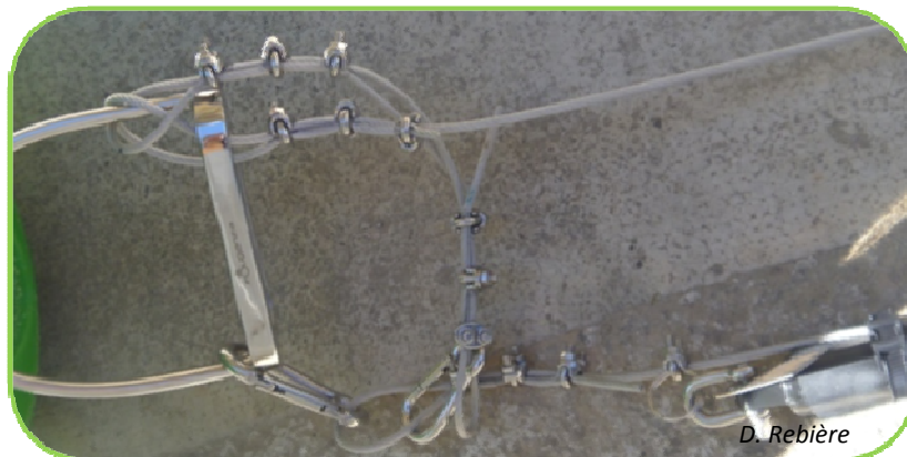
Figure 16. Montage du câble de sécurité entre les câbles A et B
