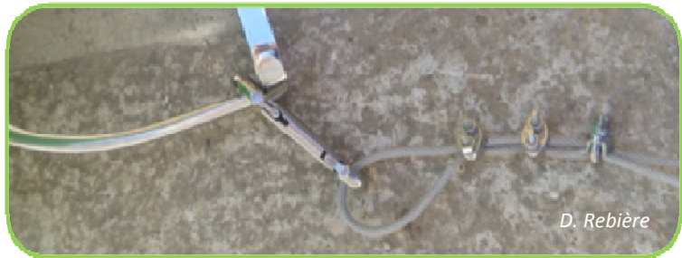
Figure 13. Montage du câble B sur une des branches de l'étrier de selle avec un mousqueton s'il n'y a pas de vandalisme
