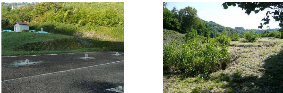
Figure 2 : Photos des filtres à sable en alimentation (à gauche) et de la ZRV type fossé (à droite)
