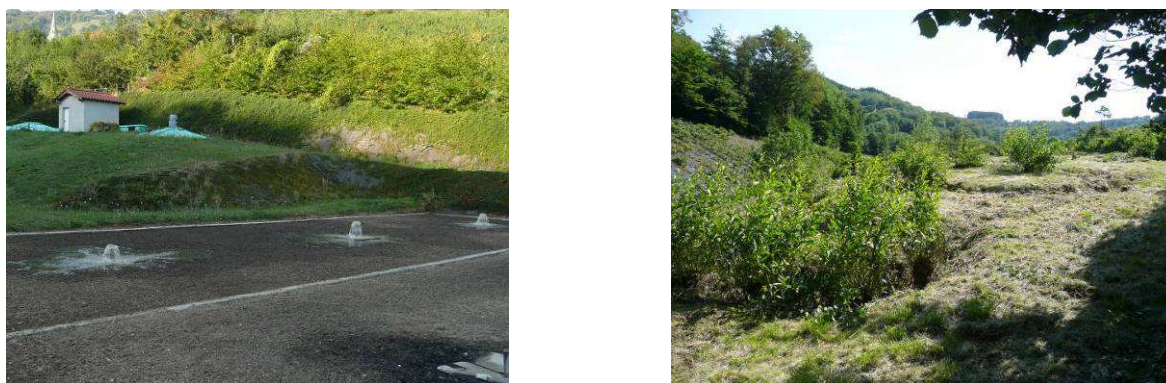
Figure 2 : Photos des filtres à sable en alimentation (à gauche) et de la ZRV type fossé (à droite)
