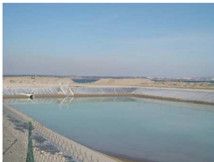
Figure 9: Bassin de rétention des eaux pluviales à Levallois-Perret (92) (www.cavaou-gnl.com)
