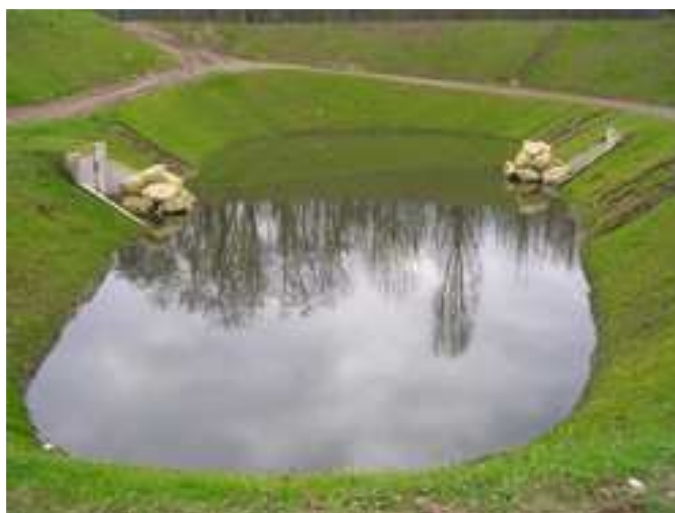
Figure 12: bassin de rétention routier dans le Val d'Oise (95) ( www.val-d-oise.equipement.gouv.fr )
