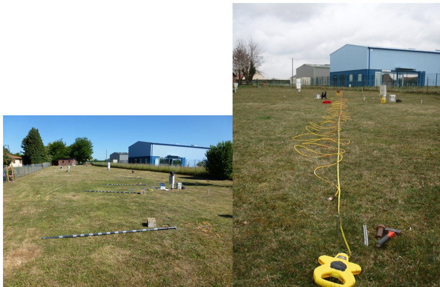
Figure 5 : Mise en place du suivi géophysique (flûtes et électrodes). Premiers résultats
