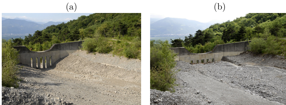
FIGURE 2.6 – Evolution de la plage de dépôt du Manival en Isère entre le 7 juin 2010 après curage (a) et le 6 juillet 2010 après crue (b) (Photos C. Peteuil).
