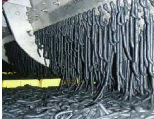
Figure 17 : Boue déshydratée extrudée entrant dans le sécheur thermique basse température
