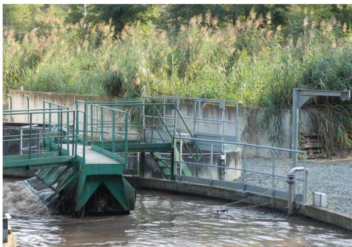
Figure 30 : Lit de séchage de boues planté de roseaux et bassin d'aération de la file eau (premier plan) du site Hs
