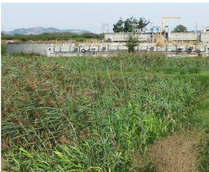
**Figure 33 : Lit de séchage de boues planté de roseaux et bassin d'aération de la file eau (arrière-plan) du site Is**
