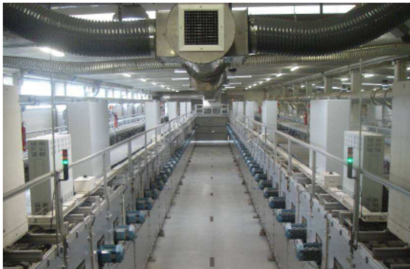
Figure 18 : Deux sécheurs basse température – marque STC
