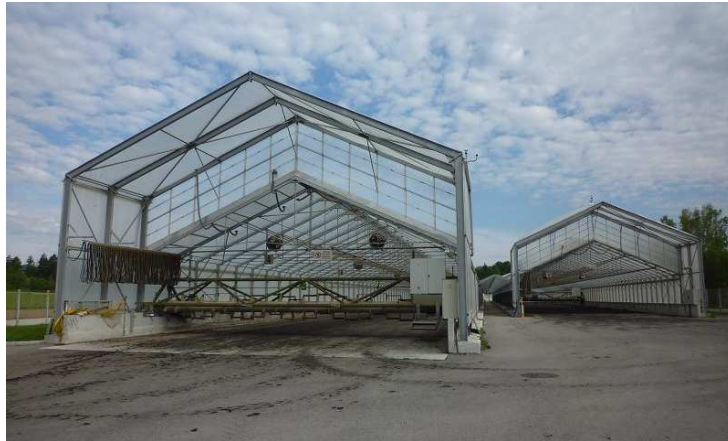
Figure 20 : Serres de séchage solaire du site Cs
