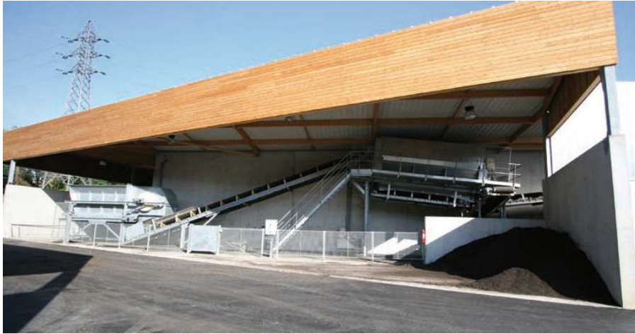
Figure 5 : Crible pour séparer le compost du support carboné
