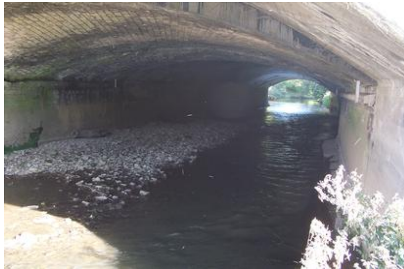
Figure 23 : intérieur de l'arche de droite du pont SNCF à bas débit
