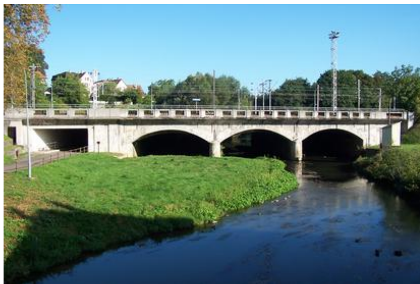
Figure 21 : Vue, à bas débit et depuis l'amont, de la station de la Sarre à Sarrebourg (code Hydro A9021010) avec au fond le pont SNCF situé en aval et au premier plan le remblai submersible situé en rive gauche
