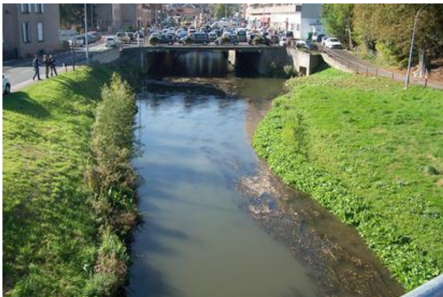
Figure 22 : le pont routier amont depuis le pont SNCF
