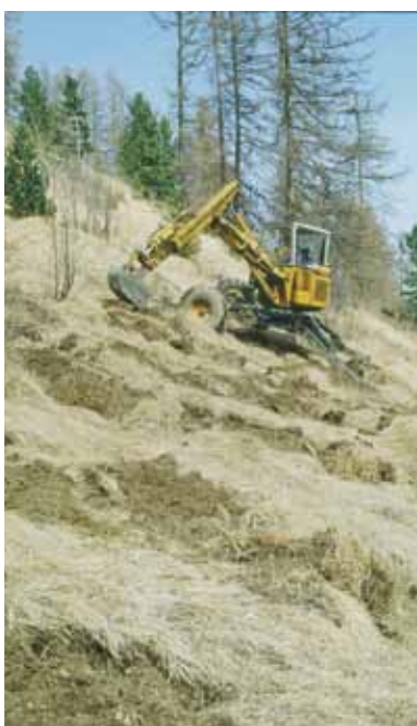
30 - La pelle araignée, en opérant ponctuellement aux endroits appropriés, permet de faire des potets travaillés en conditions difficiles. Elle accède à des pentes jusqu'à 60%.
