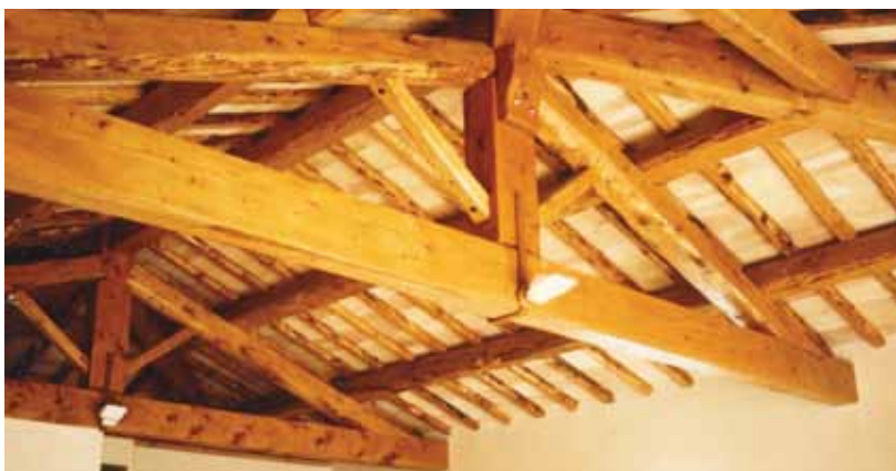
39 - Charpente en cèdre récolté au mont Ventoux.
