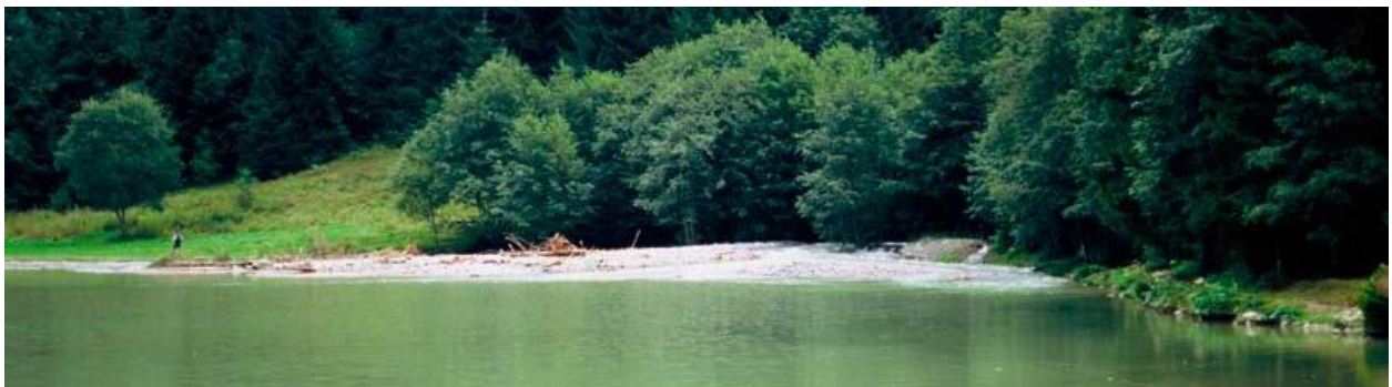
Figure 1: Dépôts massifs dans la retenue de Fond de France sur le Bréda, crue de 2005 (Isère, France) photo © IRMA (Gominet 2010)
