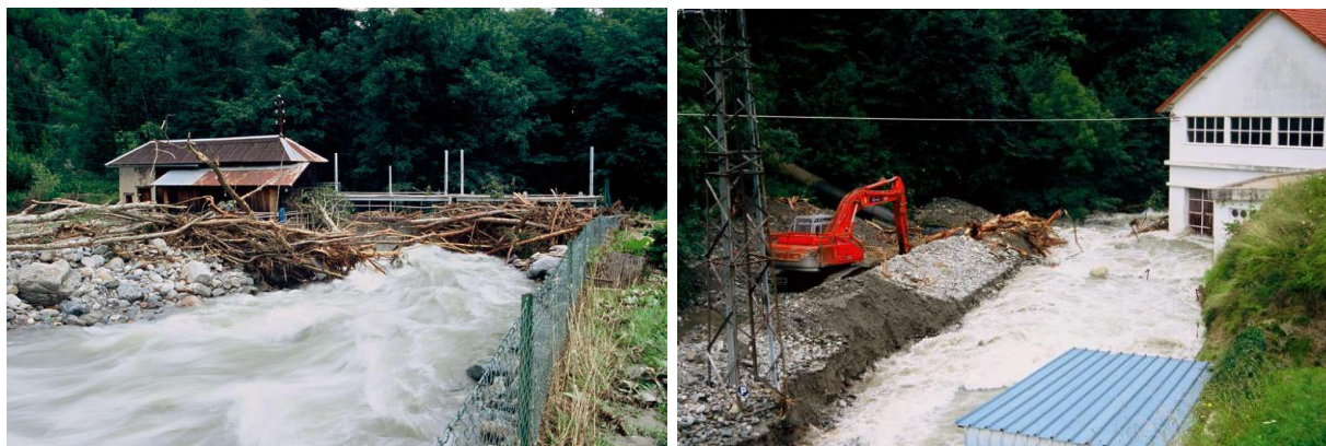
Figure 2: Crue torrentielle du Bréda en 2005 engendrant des dépôts sédimentaires, embâcles de flottants et inondations d'installation hydrauliques (Isère, France) photo © IRMA (Gominet 2010)
