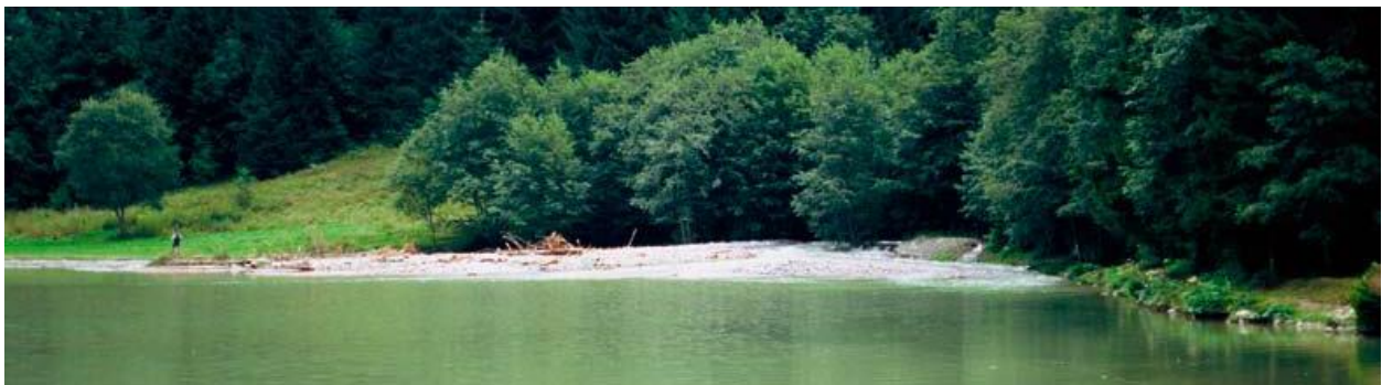
Figure 1: Dépôts massifs dans la retenue de Fond de France sur le Bréda, crue de 2005 (Isère, France) photo © IRMA (Gominet 2010)
