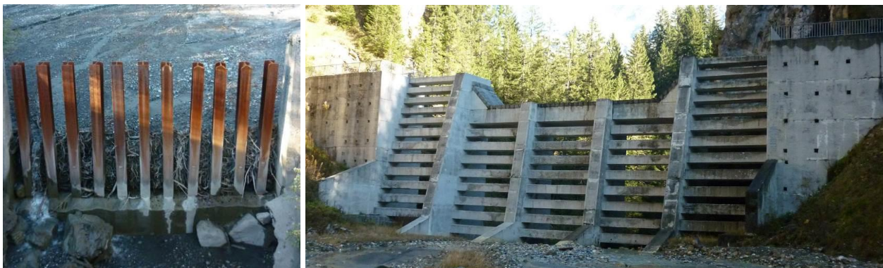
Figure 26 : ouvrages à petites ouvertures visant une rétention complète des sédiments par blocage mécanique : plages du Nant Bourdon et du Nant Rouge (Haute Savoie, France)
