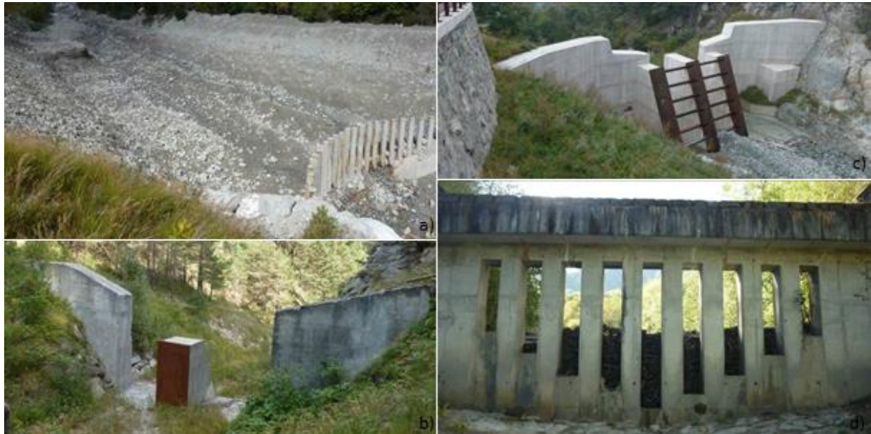
Figure 14 : Barrages filtrants : a) Barrage peigne de Rio Fosse (Val de Susa, It.) : rétention complète par blocage mécanique des galets ; b) Barrage à dent de Rio Joans (Val de Susa, It.) piégeage sélectif des gros blocs par blocage mécanique ; c) Barrage à fentes large équipées de grilles aciers du Torrent de Grand Valey (Val d'Aoste, It.) : rétention des événements extrêmes liée au colmatage des grilles par blocage mécanique de gros blocage et d) Barrage à pertuis du Lavanchon (Isère, Fr.) : modulation par contrôle hydraulique + rétention complète par blocage mécanique des flottants
