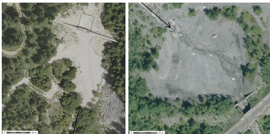
Figure 25 : Vue aérienne des plages de dépôt de la Gresse (Isère, France) et du Nant Bourdon (Haute Savoie, France) : bassin élargi promouvant l'étalement de la lame d'eau et le dépôt des graviers, situé de plus à des ruptures de pente naturelles (photos géoportail.fr)
