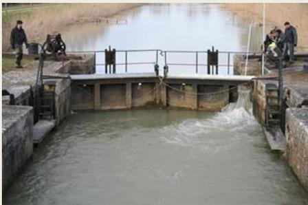
**Ouvrage de Biard.** Portes à flot fermées, admission diurne par surverse par la petite vantelle haute ouverte en rive droite.
