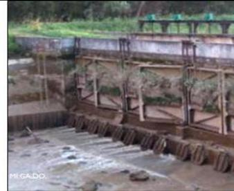
Série de portes à flot plus clapets de fond doublée d'une ligne de vannes murales © Migado
