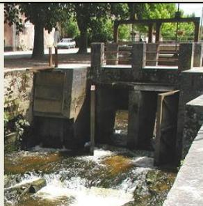
Ouvrage composite (*deux clapets en RD + 2 vannes mono-bloc amont + 2 portes à flot aval en RG*)
