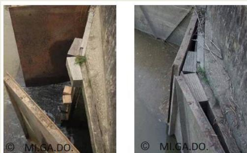
Pose de cales (à 3 niveaux) sur le cadre d'une porte à flot - Position ouverte au jusant et fermée à marée haute © Migado
