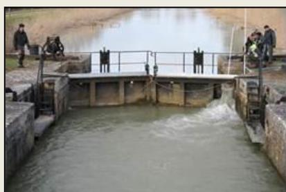
Admission d'eau par vanelle de surface obturable (ouvrage de Biard, Charente-Maritime) © CG 17 et Pôle Ecohydraulique
