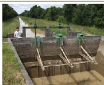
Ouvrage composite (*2 vannes levantes + 3 clapets*)
