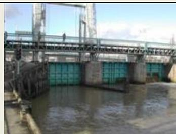
Barrage Saint Félix à Nantes (*l'une des portes levantes est la vanne aval de l'écluse de navigation*).
