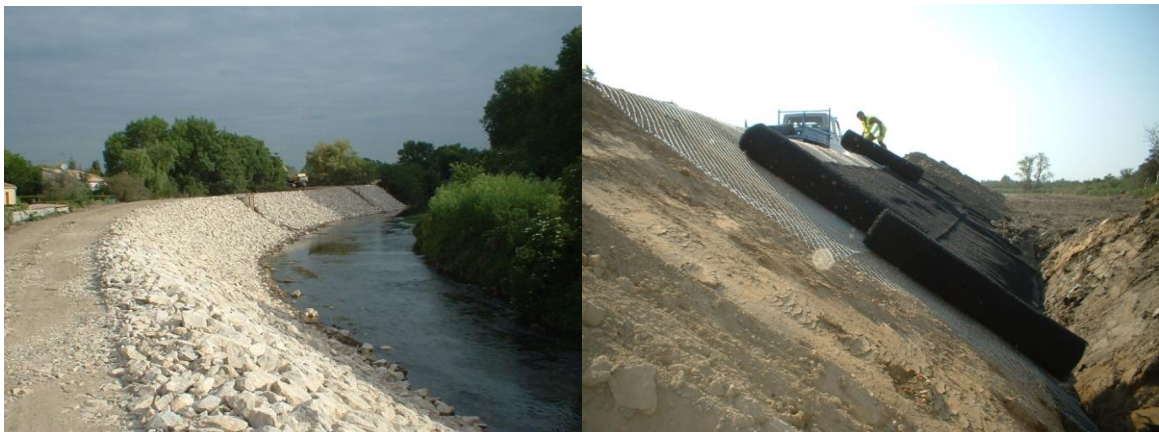
Figure 4.3 : Protection en enrochement coté rivière et mise en place d'un grillage anti-fouisseur et géosynthétique de renforcement de la terre végétale côté zone protégée
