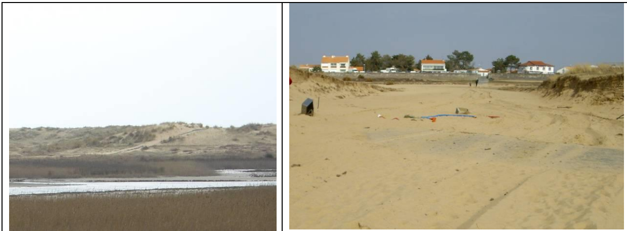
Figure 2.30 – Cordon dunaire de la Faute sur mer : a- Passage piéton engendrant un point bas sur la dune ; b- Brèche dans la dune lors de la tempête Xynthia, au droit d'un passage piéton ainsi que de câbles et d'une conduite – Source Irstea.
