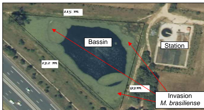
Figure 21 : Photographie aérienne du site BASSIN 2. Source ARPE
