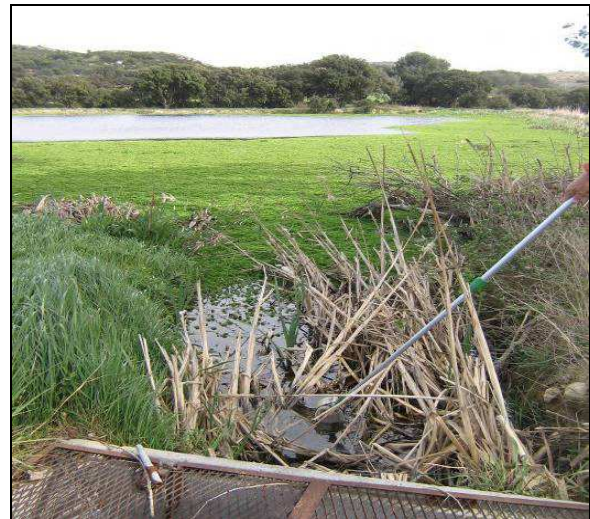
Figure 23 : Obstruction du point d'alimentation du bassin par des myriophylles. Source Irstea
