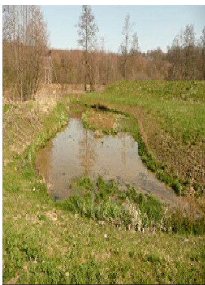
Figure 49 : Vue n°1 de la ZRV « FOSSE 7 »
