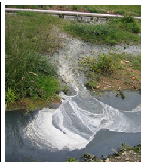
FOSSE 6 : alimentation de la ZRV par une eau septique
