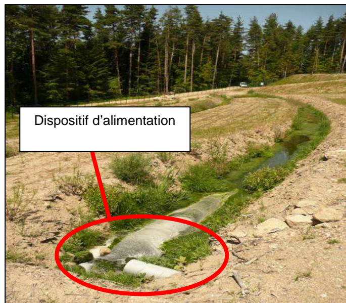
Figure 58 : Dispositif d'alimentation de « FOSSE 10 ». Source Irstea
