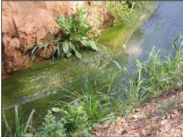
Figure 45 : Formation d'une couche d'algues au fond du fossé. Source ARPE.
