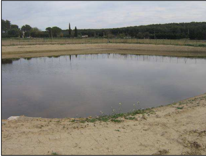
Figure 38 : Vue du « BASSIN 10 ». Source Irstea
