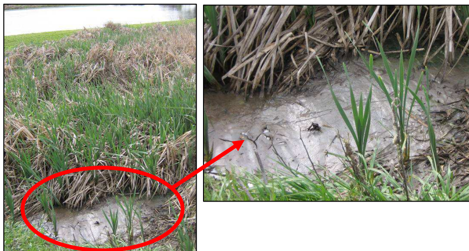
Figure 24a et 24b : Formation de boues dans « BASSIN 2 ». Source Irstea
