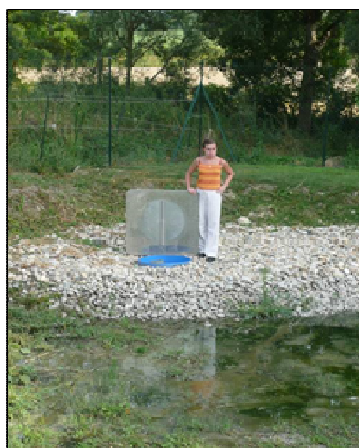
Figure 28 : Trop plein du « BASSIN 5 ». Source Irstea
