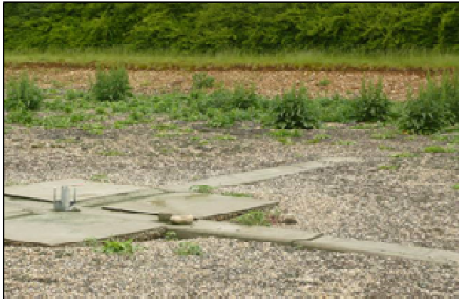
Figures 63a et b : Alimentation en affluent de la ZRV « Autre 2 ». Source Irstea
