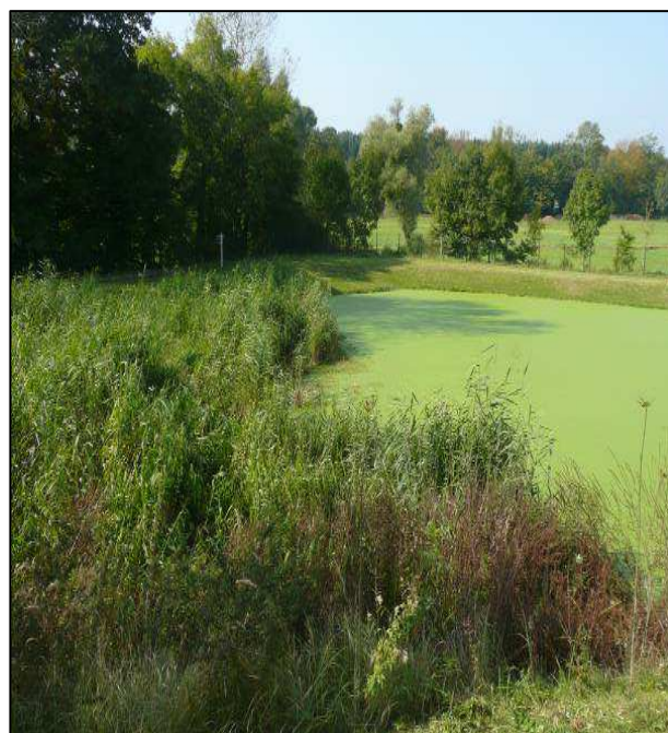
Figure 76 : Invasion de lentilles d'eau sur le bassin 2 de « AUTRE 6 ». Source Irstea
