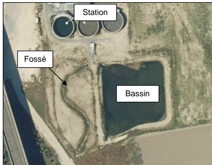
Figure 37 : Vue aérienne du site BASSIN 10. Source ARPE.
