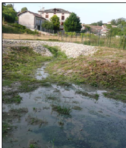
Figure 27 : Aspect du « BASSIN 5 ». Source Irstea
