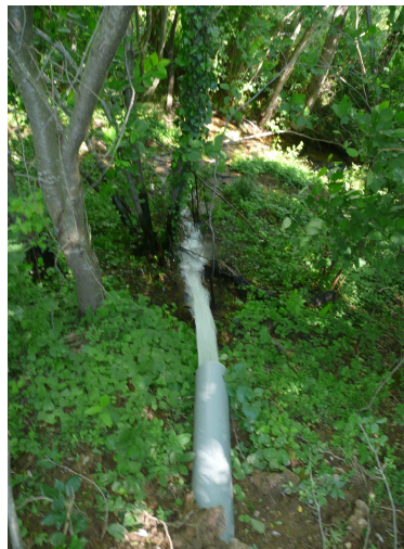
Figure 12 : Evacuation de la ZRV. Source Irstea
