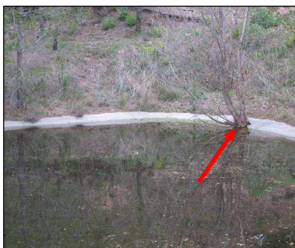
Figures 73a et b : Arbre poussant à travers la géomembrane, Affaissement localisé de « AUTRE 5 ». Source Irstea
