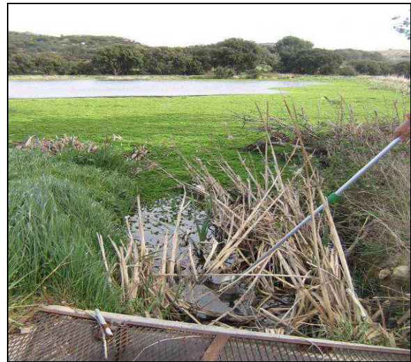
Figure 23 : Obstruction du point d'alimentation du bassin par des myriophylles. Source Irstea
