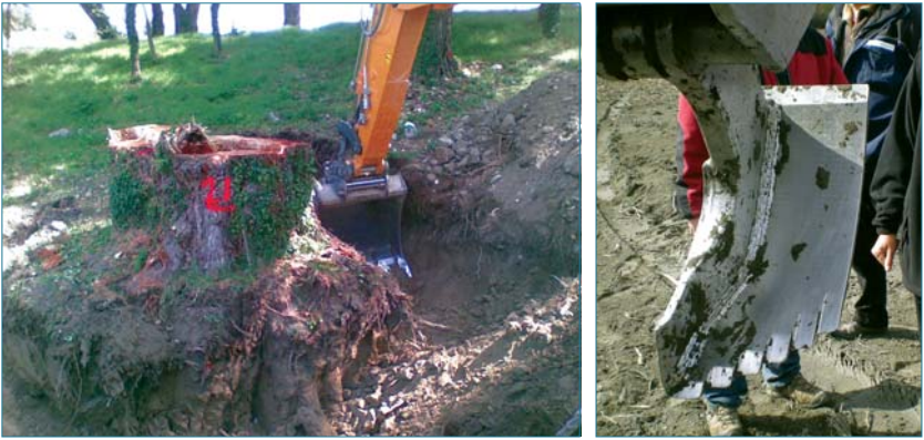
Figure 4.36. Dérivage au godet d'un gros peuplier et de ses racines principales et dent Becker, utilisée plutôt pour des petits arbres, et en matériau fin (photos M. Vennetier).
