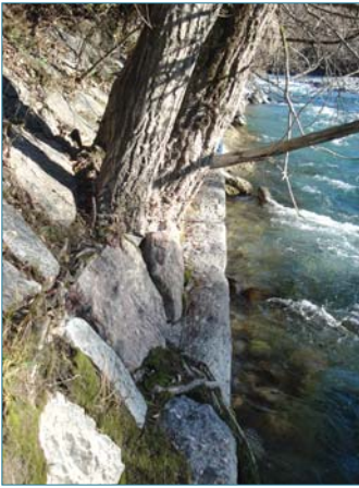
Figure 3.13 (ci-contre). Soulèvement des blocs de pierre taillés du perré maçonné par un saule arborescent (ph. C. Zanetti).
