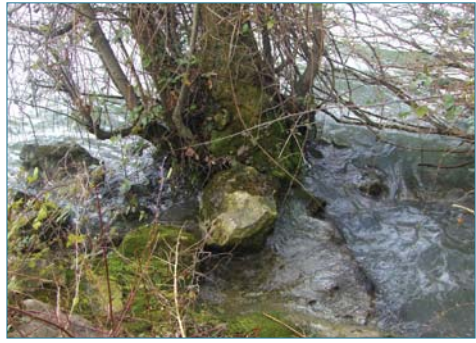
Figure 3.13 (ci-contre). Soulèvement des blocs de pierre taillés du perré maçonné par un saule arborescent (ph. C. Zanetti).
