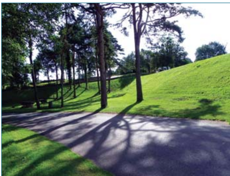
Figure 4.6. Arbres épars vers l'appui rive droite d'un talus aval de petit barrage, soigneusement fauché, même entre les troncs (ph. F. Pondevie, Dreal).
