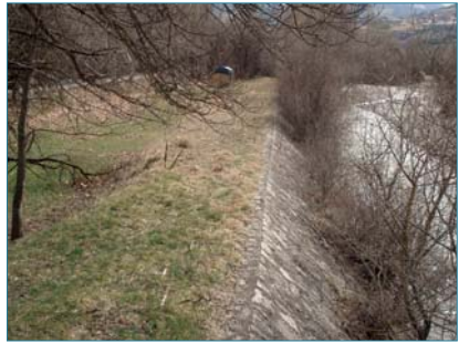
Figure 5.7. Peupliers, saules et genévriers se développant sur perré maçonné, au travers des joints (ph. P. Mériaux).
