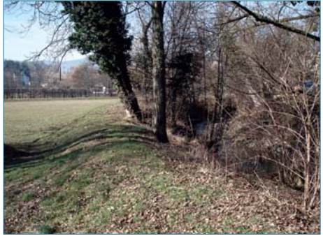
Figure 3.2. Petite digue de l'Albanne (73) perchée en haut de berge abrupte (ph. C. Zanetti).
