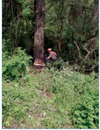
Figure 4.25. Abattage d'un gros arbre en pied de digue (ph. C. Ripert).
