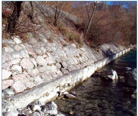
Figure 4.38. Arbres et arbustes installés sur le perré jointoyé de la digue rive droite du Guil à Eyglies (05), sans indice majeur de déstructuration (ph. P. Mériaux).
