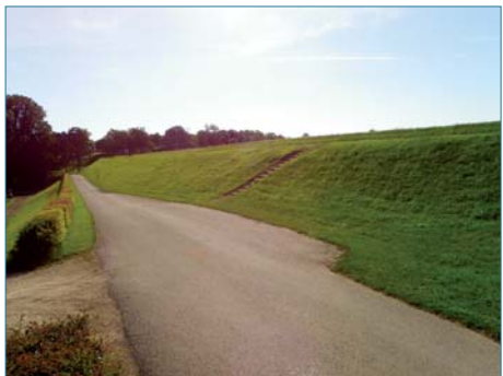
Figure 4.2. Parement aval enherbé de petit barrage, juste après une tonte. Conditions idéales pour un examen visuel (ph. F. Pondevie, Dreal).
