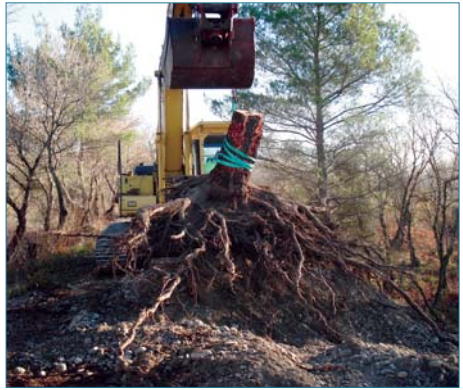
Figure 4.22. Arrachage d'un arbre avec une grande partie de son système racinaire qui a été préalablement dégagé (ph. C. Zanetti).
