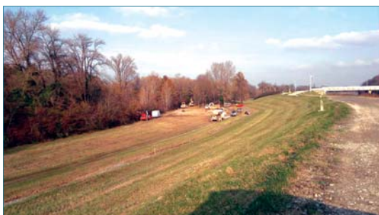
Figure 5.20. Après travaux de dessouchage (ph. EDF).
