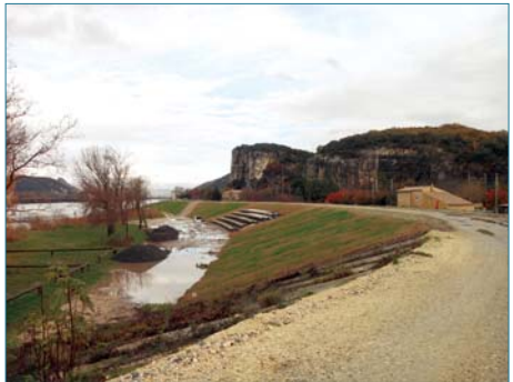
Figure 5.24. Actuellement, après la réalisation du confortement de la digue (ph. CNR/EDF).
