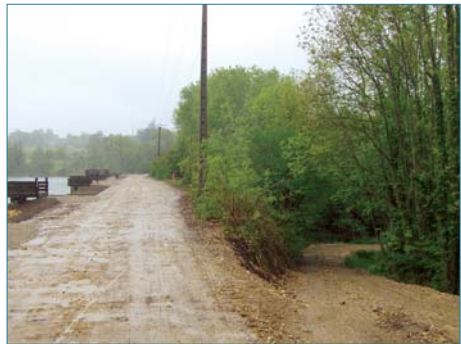
Figure 3.10. Barrage sur la Gervonde en Isère après une première tranche de rénovation. Le talus amont portait des gros peupliers qui ont été éliminés. Le plan de gestion de la végétation du talus aval doit tenir compte de la présence d'espèces animales rares à proximité (ph. C. Zanetti).
