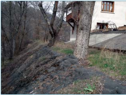
Figure 5.6. Peupliers en crête, à l'aplomb du masque en galets liés au bitume (ph. P. Mériaux).
