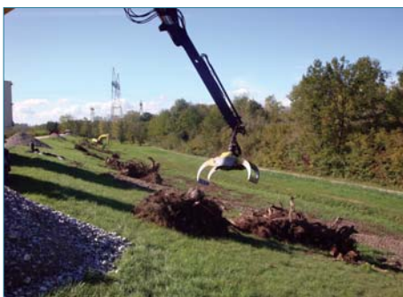
Figure 5.19. Pendant travaux de dessouchage (ph. C. Zanetti).
