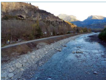
Figure 5.10. État immédiatement après travaux (lot aval). Les arbres du parement côté zone protégée de la digue sont conservés. À comparer avec la figure 5.8 (ph. P. Mériaux).
