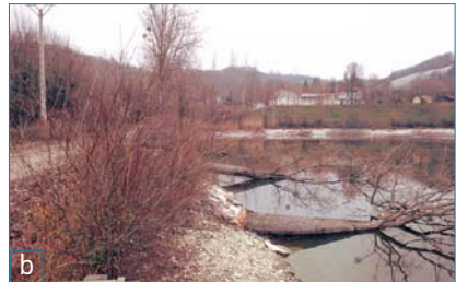
Figure 5.25 a et b. Peupliers au sommet du parement amont avant (2007), puis en cours d'abattage (2009) (photos (a) Géo+Environnement et (b) Cemagref/Irstea).
