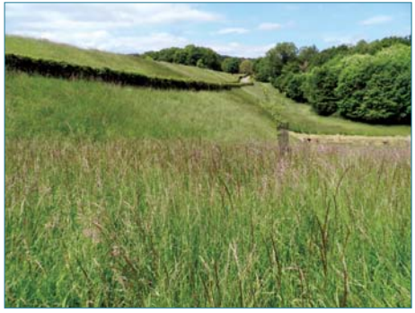
Figure 4.3. L'absence de fauche récente rend difficile l'examen visuel du parement aval enherbé de ce barrage (ph. P. Mériaux).
