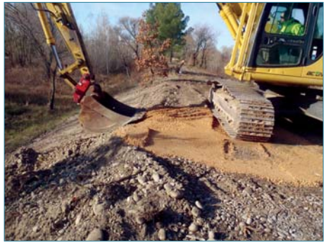
Figure 4.23. Réfection du talus et de la crête de digue, après élimination des arbres dangereux : régularisation de la pente, apport local et tassage de matériaux (ph. C. Zanetti).
