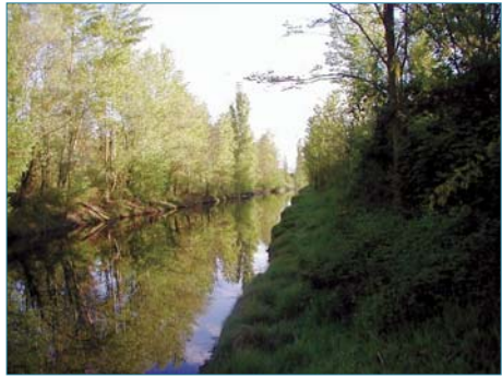
Figure 3.20. Ambiance bucolique le long de cette rivière ombragée par ses digues. La végétation de type 6 (arbres et arbustes denses) gêne la surveillance visuelle et fragilise les ouvrages, qui ne sont ni très hauts ni larges, et qui se situent dans la continuité des berges potentiellement instables, car assez raides (ph. C. Ripert).
