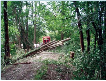
Figure 5.13. Exploitation des arbres dans un secteur fortement boisé. Dans les zones critiques pour la sécurité, les souches des plus gros arbres ont été arrachées et le remblai reconstitué (ph. C. Ripert).
