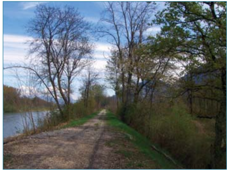
Figure 3.3. Dighe de l'Isère alternant des zones herbacées sur des talus récemment rénovés, des bouquets d'arbres résiduels, des fourrés denses d'arbustes et de rejets d'arbres coupés (ph. C. Zanetti).
