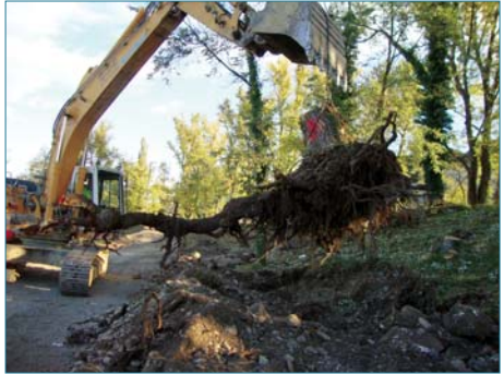
Figure 5.23. Pendant les travaux de dessouchage (ph. C. Zanetti).
