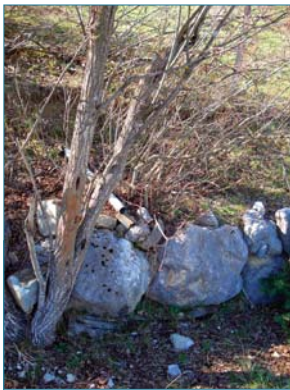
Figure 4.12a (ci-contre). Arbres et arbustes se développant au débouché aval d'un dispositif de drainage subhorizontal (ph. P. Mériaux).
