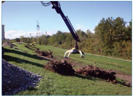
Figure 5.19. Pendant travaux de dessouchage (ph. C. Zanetti).
