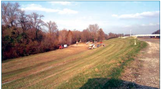
Figure 5.20. Après travaux de dessouchage (ph. EDF).
