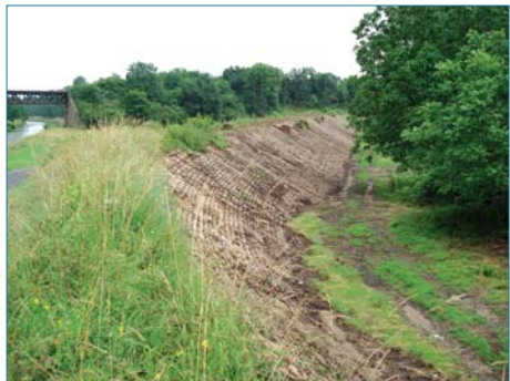
Figure 3.5. Dighe de la Loire avec perré maçonné. Noter les rejets de souche d'arbres poussant directement dans le perré et récemment coupés (ph. C. Zanetti).
