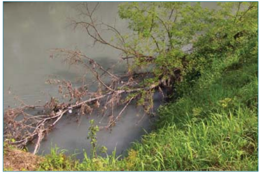
Figure 1.2. Affouillement du pied d'une digue par des courants tourbillonnaires derrière un arbre tombé (ph. C. Zanetti).
