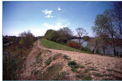
Figure 4.35. Recharge aval partielle sur drain-filtre géocomposite créée sur la digue rive gauche du Petit Rhône à Trinquetaille-Cazeneuve suite à la crue du 8 janvier 1994. (a) Coupe schématique (figure P. Mériaux/Irstea). (b) photos des travaux et du confortement terminé (photos P. Mériaux).
