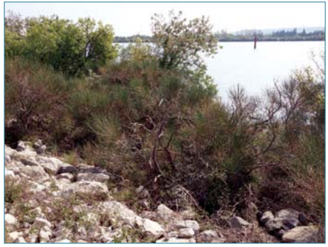
Figure 4.26. Fourré arbustif dense mêlé de petits arbres ayant envahi un enrochement sur le talus amont d'une digue. L'entretien est difficile à cause des blocs qui gênent le passage d'un engin et l'emploi d'un broyeur classique (ph. M. Vennetier).
