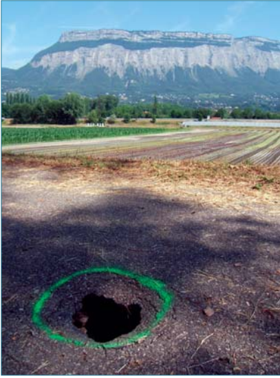
Figure 1.9. Effondrement en crête de digue lié à la décomposition d'une souche (ph. J.-F. Gomez).
