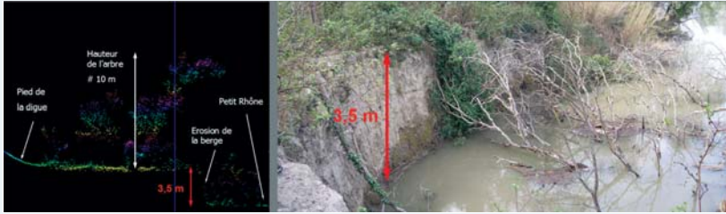
Figure 4.27. Caractérisation en coupe et en plan de la végétation de bord de digue à l'aide des outils Lidar (© Irstea et Fugro, source : projet Flimap digues, ph. P. Mériaux).
