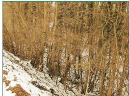
Figure 5.27. Taillis dense sur le parement aval du barrage (ph. Cemagref/Irstea).
