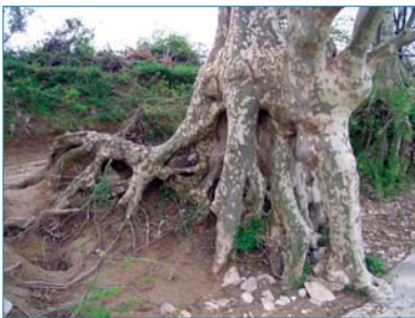
Figure 1.8. Racines exposées sur une portion de digue érodée. On peut imaginer aussi bien : 1) le rôle protecteur et stabilisant joué par ce système racinaire, dont certaines racines s'enfoncent dans le talus ; 2) le rôle de plan de glissement qu'il a pu jouer pour la couche de terre sous laquelle il s'est développé initialement, et qu'il a pu déstabiliser à cause de la croissance en diamètre des racines ; 3) le danger que représente un tel système racinaire s'il vient à se décomposer dans la digue, créant de larges vides, ou s'il était arraché avec l'arbre lors d'une tempête, emportant avec lui l'ensemble du remblai qu'il a entièrement colonisé. (ph. Irstea).
