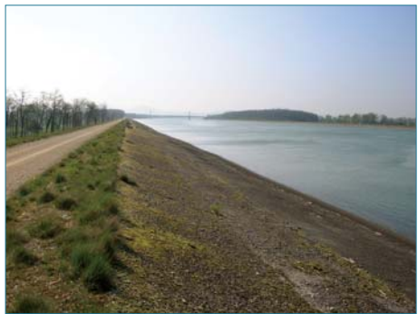
Figure 3.7. Digue de canal du Rhône (XX e siècle) (ph. C. Zanetti).
