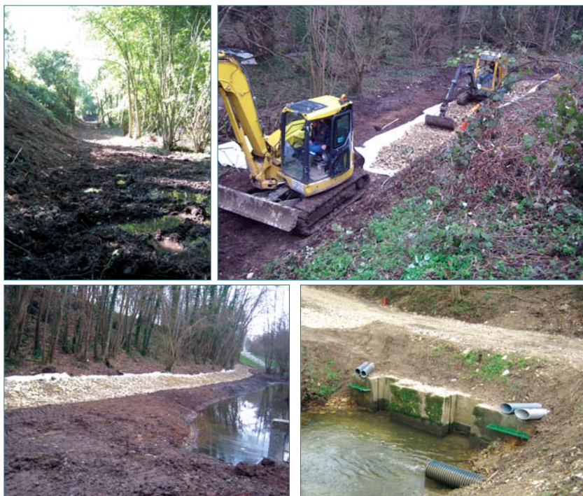
Figure 5.30. Chantier de construction du cavalier de pied filtre-drain (septembre 2013). En bas, ouvrage réalisé, avec exutoire des collecteurs de drainage (photos conseil départemental de l'Isère).
