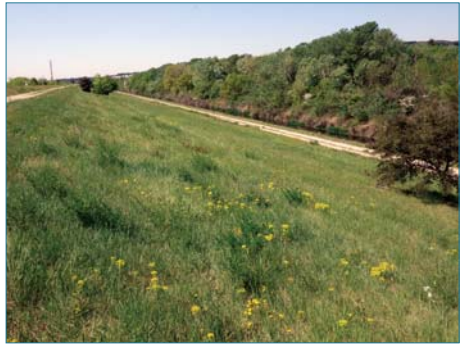
Figure 3.17. Arbustes très dispersés sur une digue fauchée régulièrement (type 2). Une densité double d'arbustes serait encore considérée comme type 2 (ph. M. Venetier).
