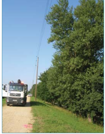
Figure 5-18. Avant les travaux de gestion de la végétation (ph. C. Zanetti).
