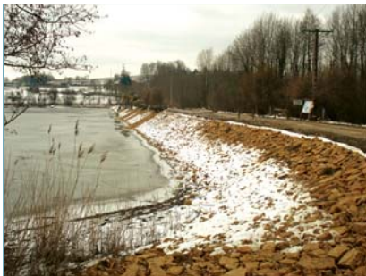
Figure 5.26. Parement amont après les travaux de reprise de la protection anti-batillage (2010) (ph. Cemagref/Irstea).
