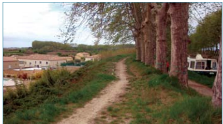
Figure 3.8. Digue du canal du Midi (XVIII e siècle) (ph. C. Zanetti).
