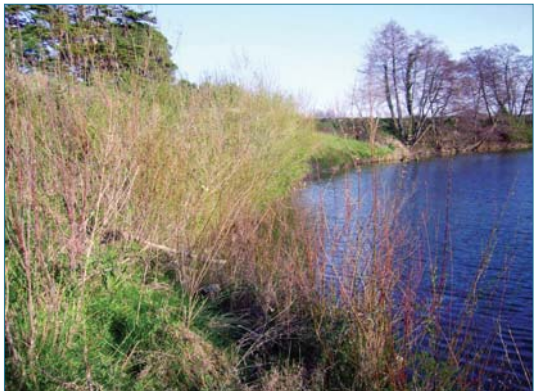
Figure 5.4. Stabilisation d'un talus de berge et digue par génie végétal dans un méandre après un glissement de berge ayant menacé le pied de digue (ph. M. Venetier).
