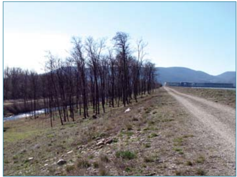
Figure 4.7. Talus aval boisé de digue d'aménagement hydroélectrique. Sous-bois débroussaillé, puis entretenu en pelouse (ph. P. Mériaux).
