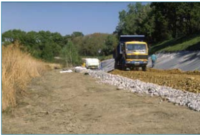
Figure 4.35. Recharge aval partielle sur drain-filtre géocomposite créée sur la digue rive gauche du Petit Rhône à Trinquetaille-Cazeneuve suite à la crue du 8 janvier 1994. (a) Coupe schématique (figure P. Mériaux/Irstea). (b) photos des travaux et du confortement terminé (photos P. Mériaux).
