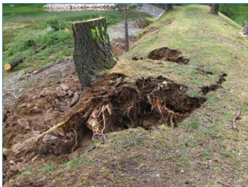
Figure 1.19. Système racinaire d'un mélèze ayant déstabilisé une digue sur plus de la moitié de sa largeur. Certaines grosses racines s'enfoncent profondément au cœur de l'ouvrage (ph. Zanetti C.).
