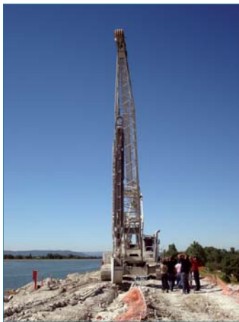
Figure 4.28. Création d'une paroi moulée épaisse à la berlinoise sur une digue d'aménagement hydroélectrique et un barrage (à gauche) et d'une paroi mince sur une digue de protection en Pologne (à droite) (photos P. Mériaux).
