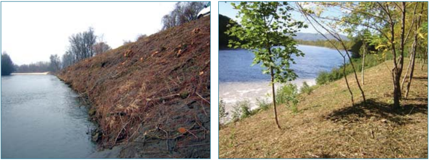
Figure 5.15. Remise en état de talus de digue par coupe rase (à gauche) et débroussaillage d'entretien (à droite) (photos J.-F. Gomez, AD Isère).
