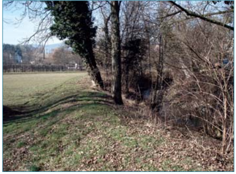
Figure 3.2. Petite digue de l'Albanne (73) perchée en haut de berge abrupte (ph. C. Zanetti).
