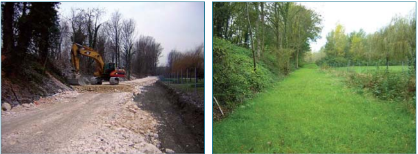
Figure 5.16. Travaux de stabilisation d'un talus contre les glissements (à gauche) et végétalisation du massif drainant (à droite), après déboisement du pied de talus et de ses abords (photos J.-F. Gomez, AD Isère).
