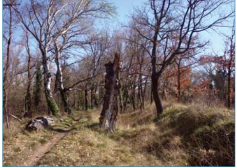
Figure 3.1. Petite digue du Verdon (83) implantée sur un ségonnal, à plusieurs mètres de la berge du cours d'eau (ph. C. Zanetti).
