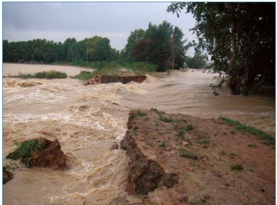
Figure 1.11. Formation d'une brèche sur une digue du Vidourle (ph. mairie Marsillargues).
