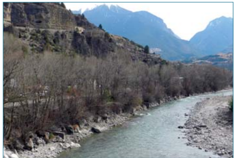
Figure 5.8. Corridor de peupliers quinquagénaires s'étant installés sur les enrochements de protection du parafouille béton. Épis en béton déchaussés par l'incision du Guil (ph. P. Mériaux).
