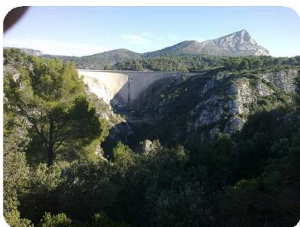
Figura 1: Presa de Bimont.
