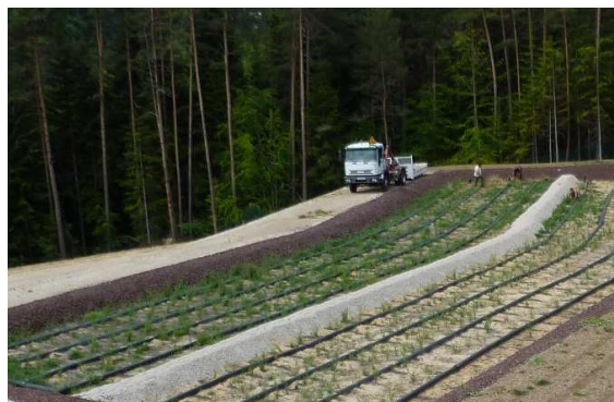
Désherbage manuel des filtres du deuxième étage au printemps. Cette opération n'est plus à réaliser lorsque la densité des roseaux est suffisante
