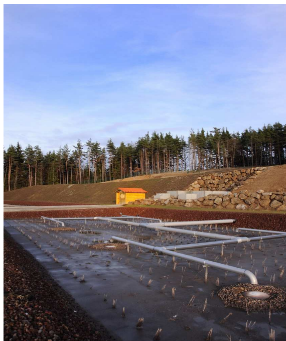
Rampe de distribution du 1 er étage
