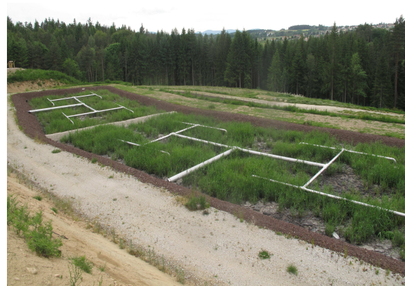
Premier étage de filtre
