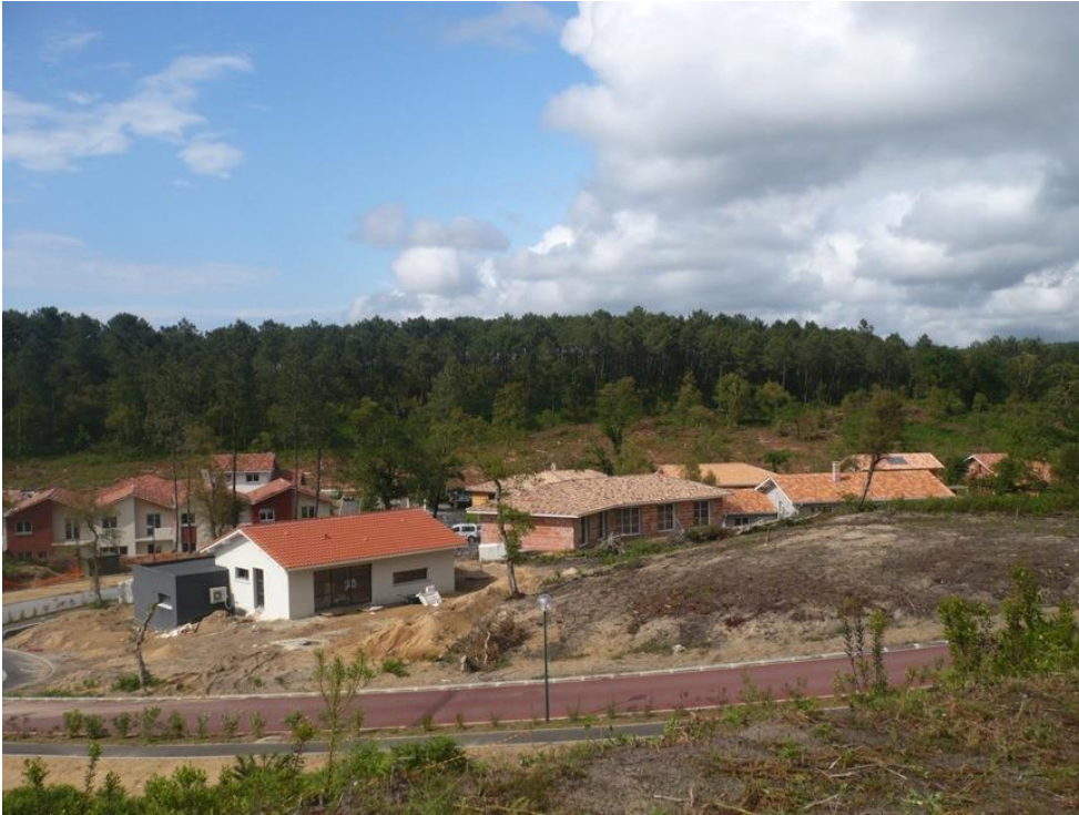
Figure 16 Lotissement en construction (Labenne). Cliché : Bouisset & Degrémont
