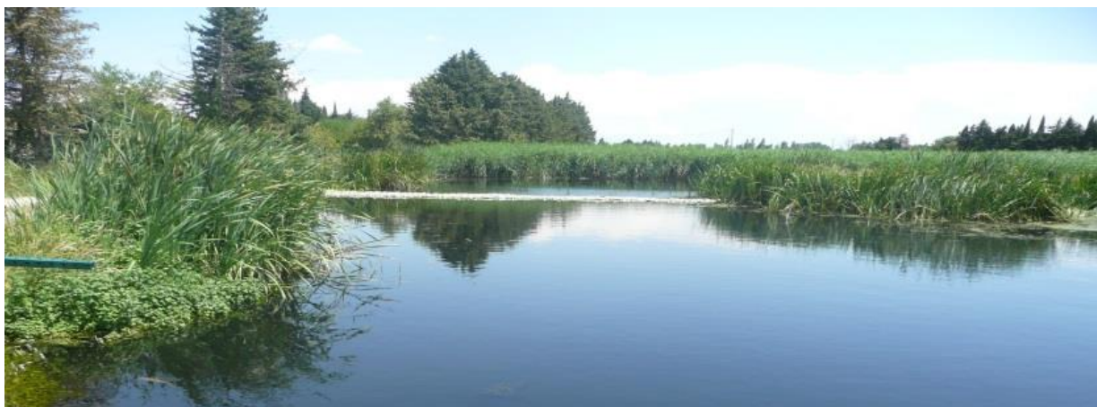
Figure 1 : Photographie d'une zone de rejet végétalisée de type bassin (photo Irstea)
