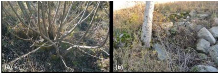
Figure 44. Souche de frêne ayant rejeté (a) et arbre mature sur tapis drainant (b) du barrage des V... (France – 05) – (photo : Bambara G., 2014)
