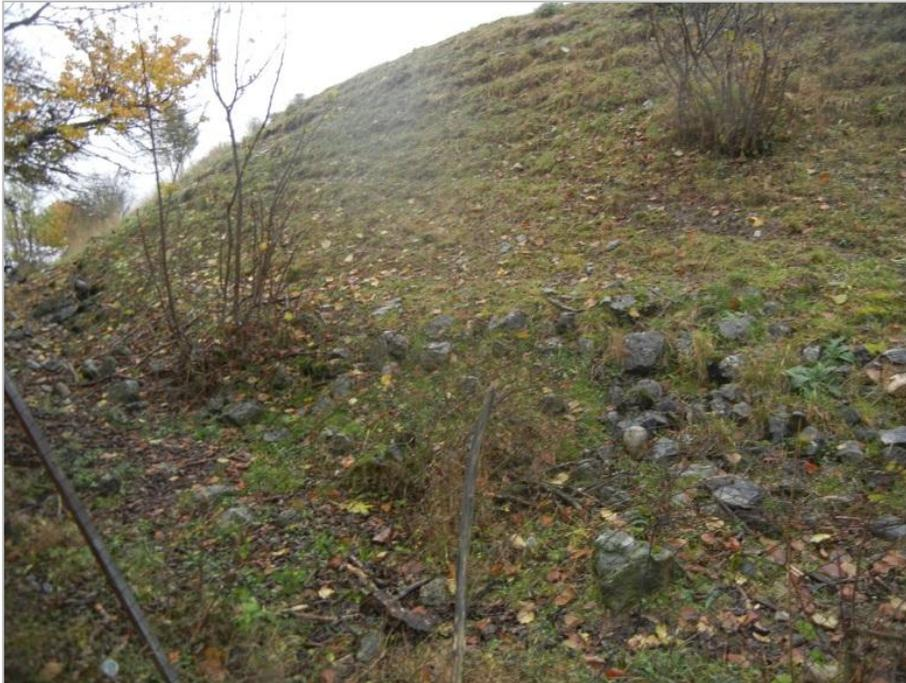
Figure 31. Tapis drainant en pied aval du barrage des G... (France – 05) – (photo : Bambara G., 2014)
