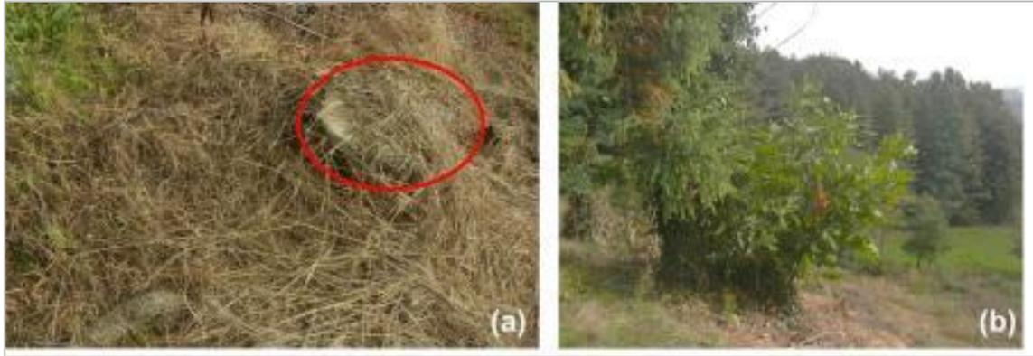
Figure 20. Souche de conifère morte (a) et souche de chêne ayant rejeté (b) sur le couronnement aval du barrage de Grengia (Italie) – (photo : Bambara G., 2014)
