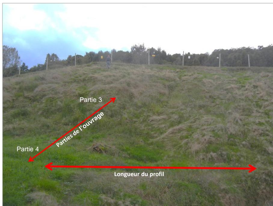
Figure 23. Profil choisi par le groupe d'experts pour l'évaluation de la performance du barrage d'O...vis-à-vis du mécanisme d'érosion interne. - (photos : Bambara G., 2014)
