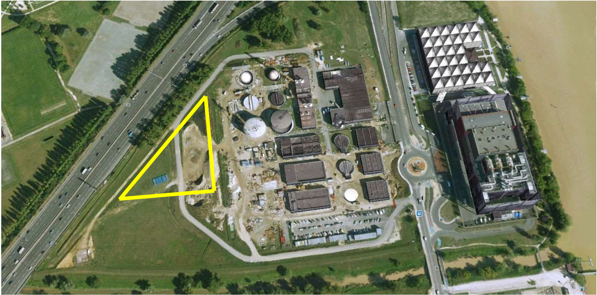
Station d'épuration Clos-de-Hilde et centre d'incinération des déchets en 2006 (source Google Earth). Le triangle jaune représente l'emplacement du site expérimental.
