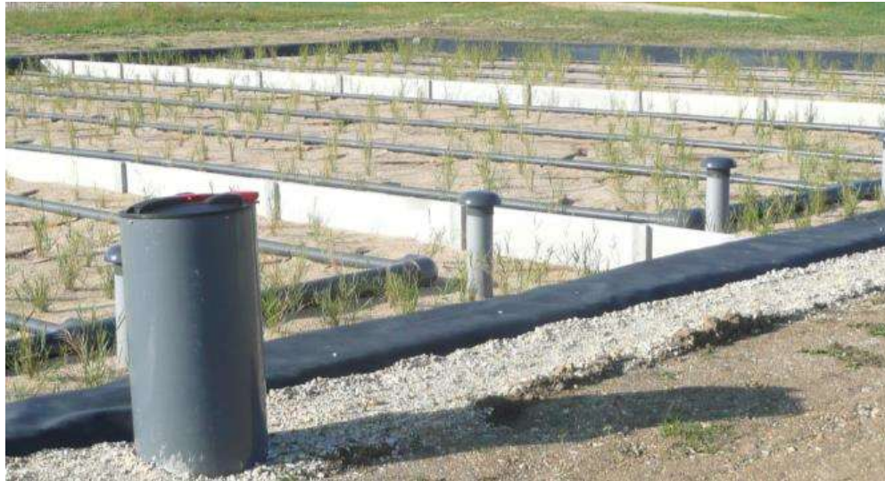
Figure 8 : Photographies du FPRv avec canalisations de distribution, cheminées de ventilation et regard de vanne motorisée
