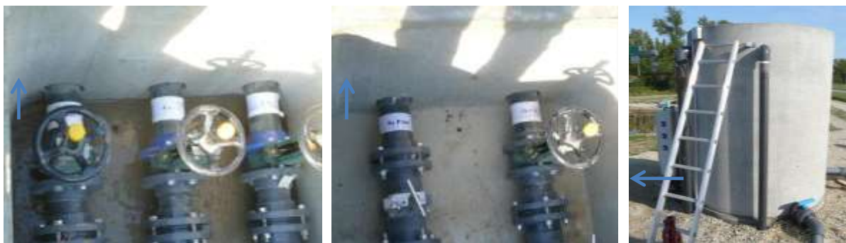
Figure 9 : Photographies des vannes manuelles (type pointeau, ou vanne de sectionnement) et bache hors-sol de distribution
