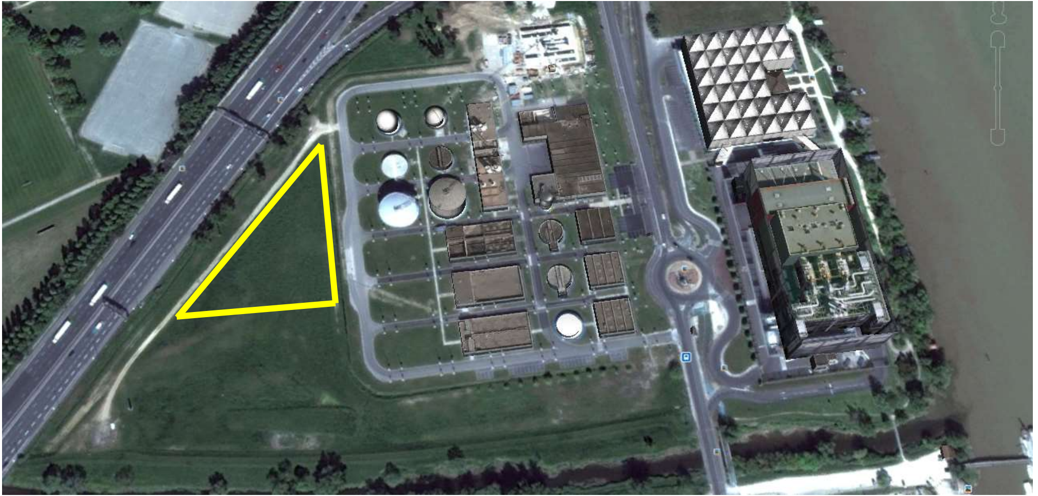
Station d'épuration Clos-de-Hilde et centre d'incinération des déchets en 2011 (source Google Earth). Le triangle jaune représente l'emplacement du site expérimental.
