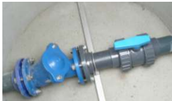
Figure 7 : Photographie du PR1(a) et du système de vanne d'isolement / clapet anti-retour (b)
