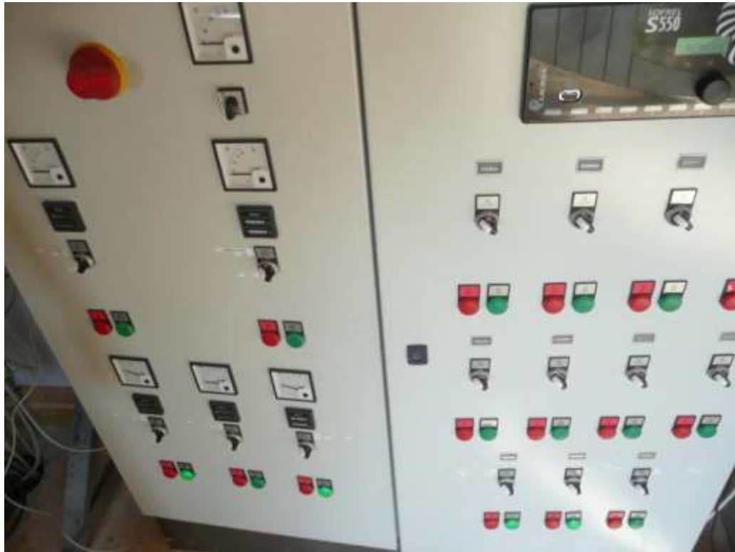
Figure 16 : Photographie de l'armoire électrique générale (commandes pompes et vannes motorisées) située dans le local d'exploitation
