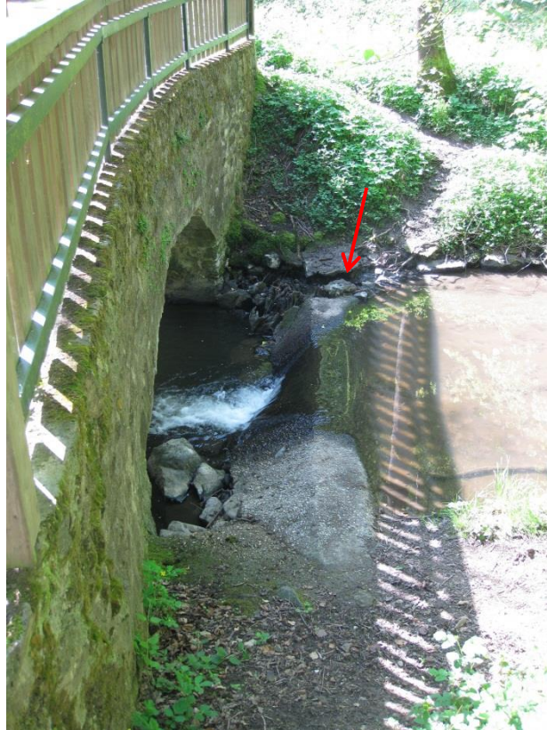
Figure 19: Photo de la section de contrôle de la station hydrométrique de Craponne. La flèche rouge indique l'emplacement de l'ancienne souche. (source : IRSTEA).
