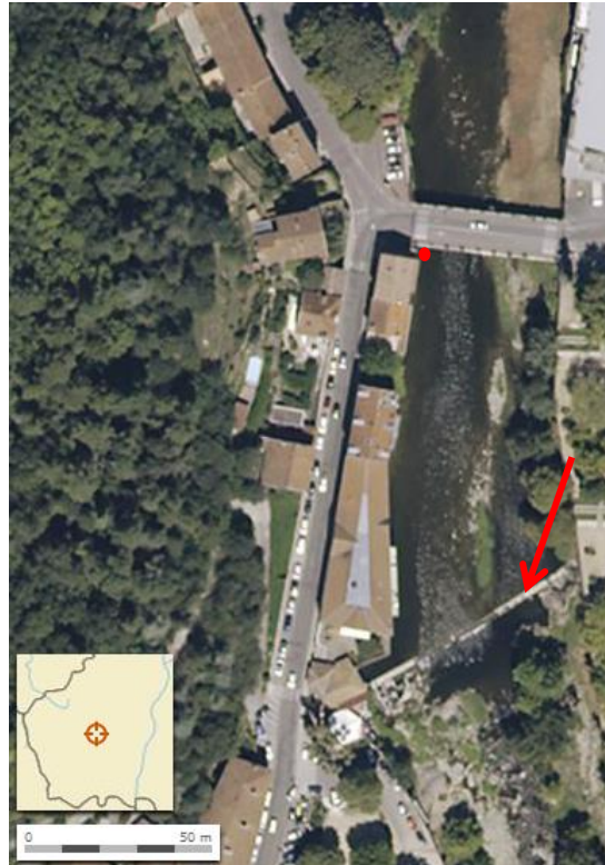
Figure 7: Photo aérienne de la station hydrométrique de Vals-les-Bains. Le point rouge indique la position du capteur et la flèche rouge la position du seuil en béton. (Source: Géoportail)
