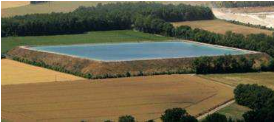
Figure 22 : Réserve créée hors de tout thalweg par déblai / remblai (Source : http://www.charentelibre.fr )
