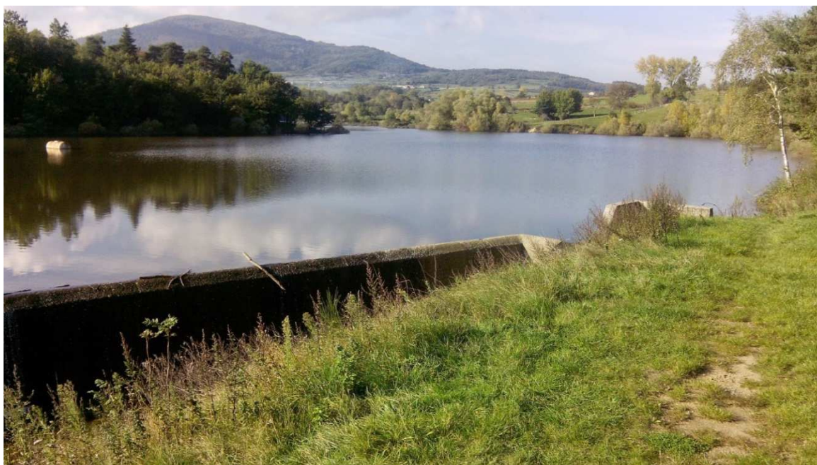
Figure 19 : Retenue de la Jointine (Source : Irstea)
