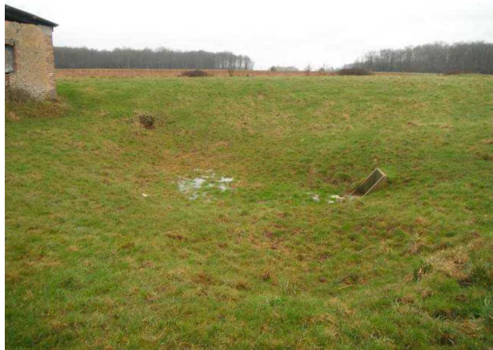
Figure 37 : Exemple de drainage débouchant dans une zone d'infiltration préférentielle à proximité du hameau de Hennedelle. Photo du bureau d'étude SOGETI
