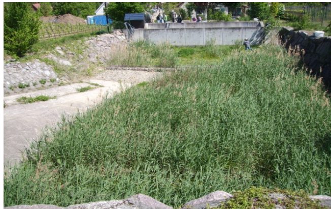
Bassin d'orage naturellement végétalisé de Rouffach (Photo : LHyGeS)
